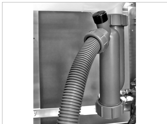
Abb. 12: Siphon mit Kondensatschlauch montieren
