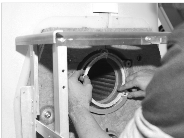
Abb. 1: Brennerdichtschnur einlegen, Stoß oben
