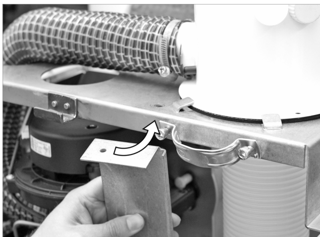
Abb. 14: Ölfilter-Halterung befestigen
