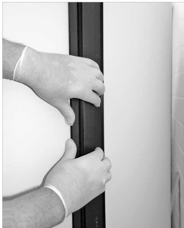
Abb. 47: Isolierung hinten schließen
