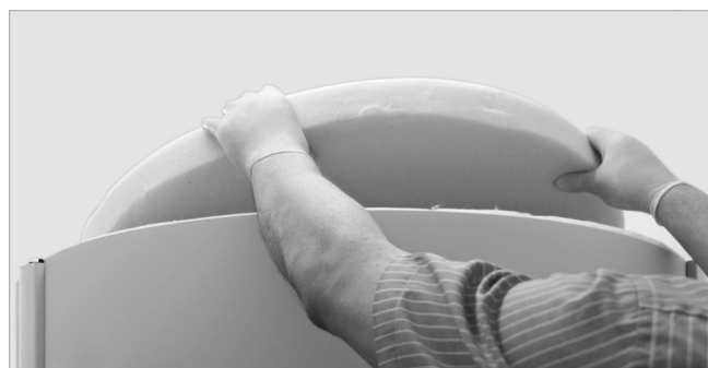
Abb. 49: Deckelrunde auflegen
