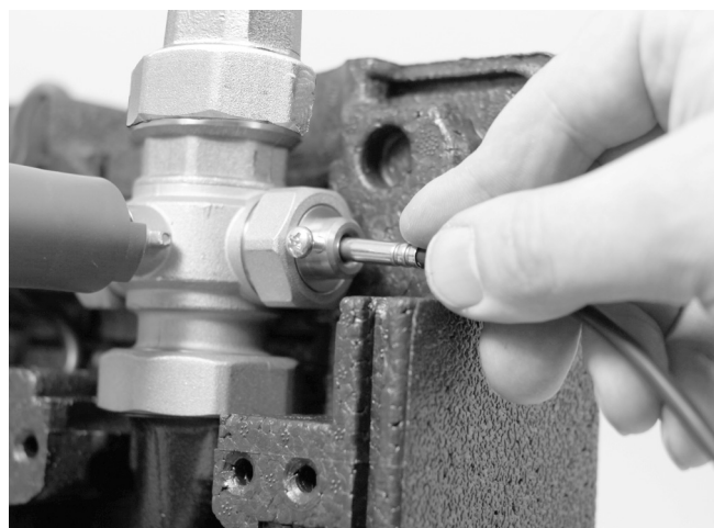
Abb. 40: Vorlauffühler montieren
