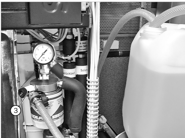
Abb. 58: Füllhahn am Filterdeckel (mit montiertem Solarkreisfilter)
