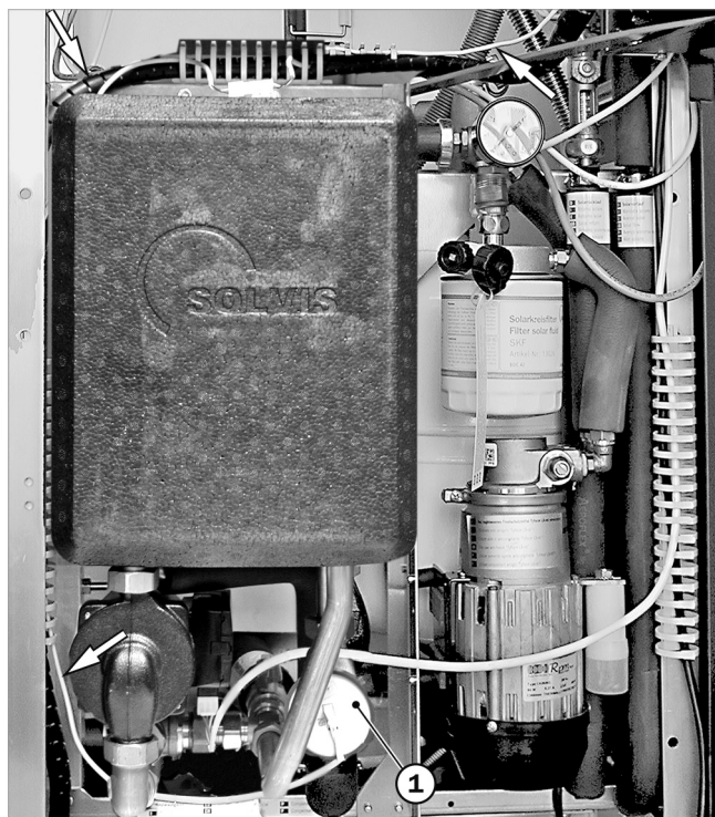
Abb. 29: Leitung VSG-W verlegen
