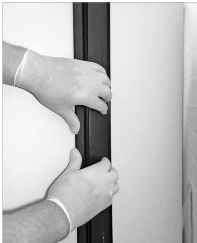
Abb. 47: Isolierung hinten schließen
