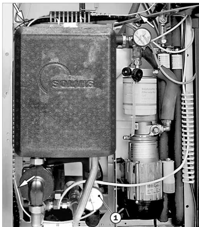
Abb. 29: Leitung VSG-W verlegen
