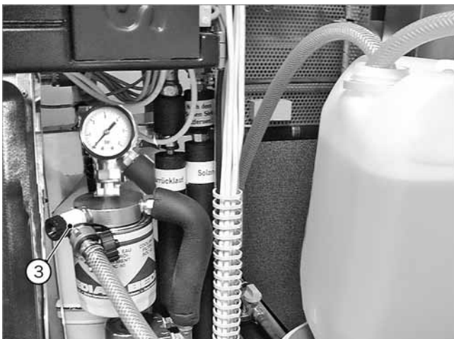
Abb. 58: Füllhahn am Filterdeckel (mit montiertem Solarkreisfilter)
