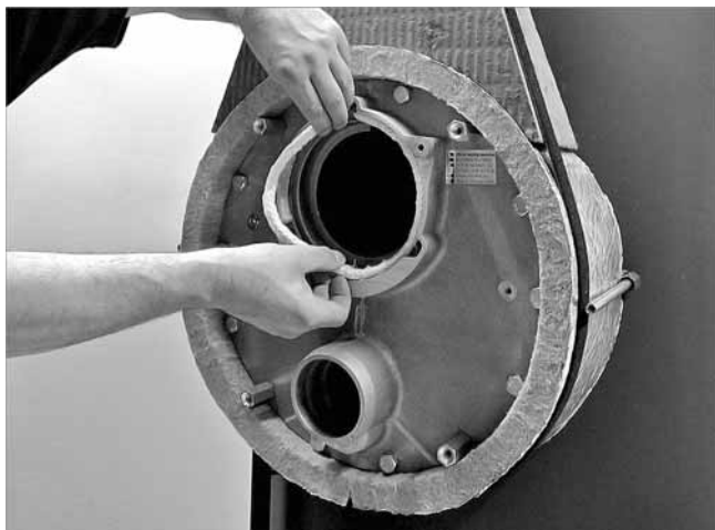
Abb. 10: Brennerdichtschnur einlegen
