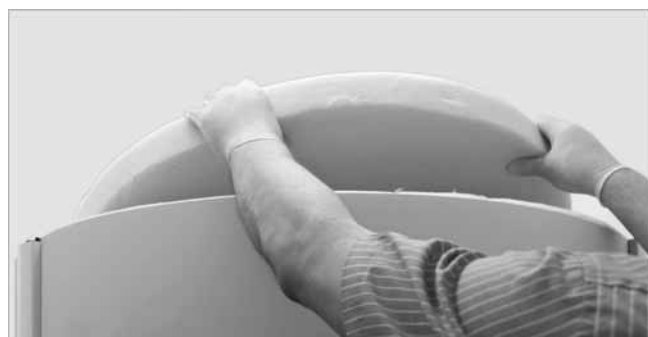
Abb. 49: Deckelrunde auflegen
