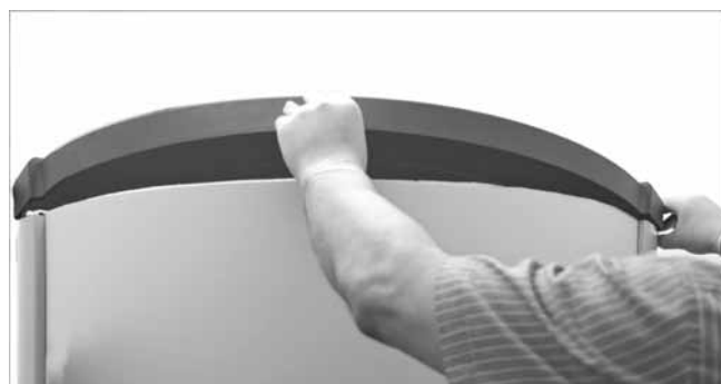
Abb. 50: Obere Abdeckung auflegen
