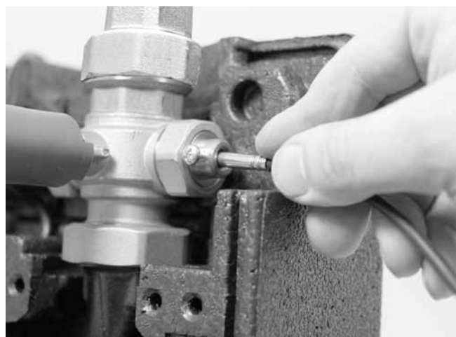
Abb. 40: Vorlauffühler montieren
