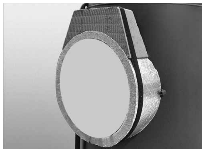
Abb.6: Flanschisolierung fixieren
