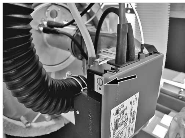
Abb. 68: Reset-Taste am Feuerungsautomat
