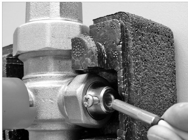
Abb. 42: Vorlauffühler montieren
