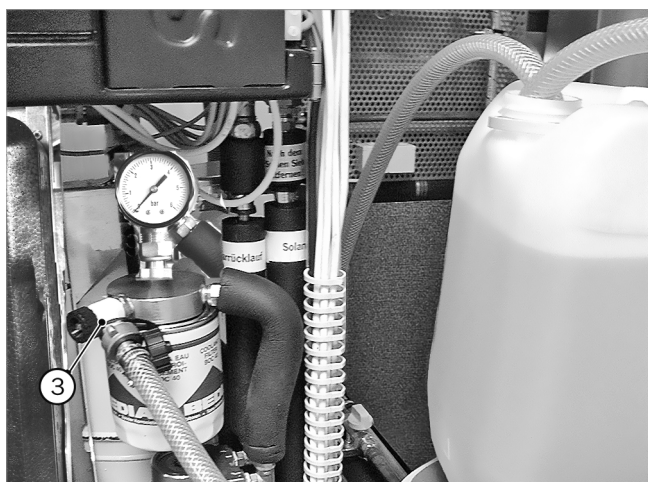
Abb. 62: Füllhahn am Filterdeckel (mit montiertem Solarkreisfilter)
