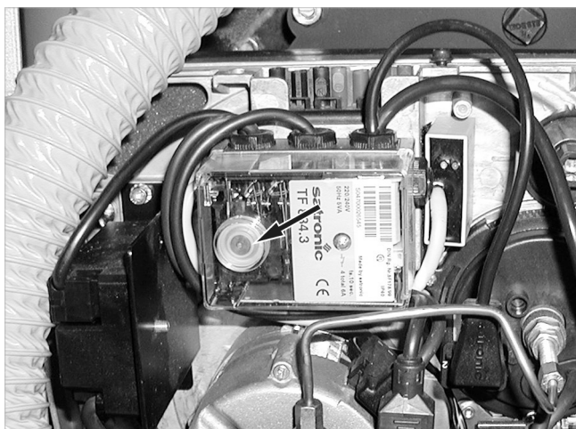
Abb. 75: Feuerungsautomat TF 834
