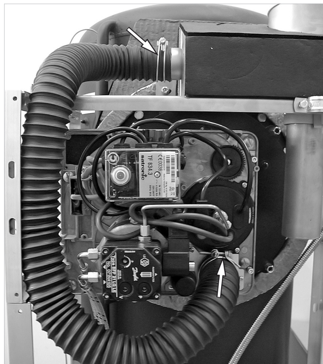
Abb. 18: Zuluftschlauch montieren
