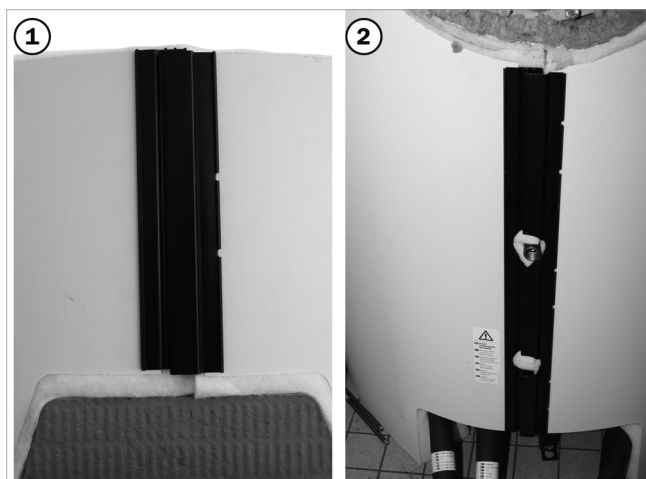
Abb. 48: Isolierung oben (1) und unten (2) schließen
