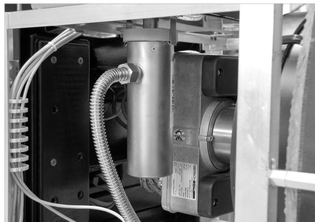
Abb. 26: Siphon mit Kondensatschlauch montieren
