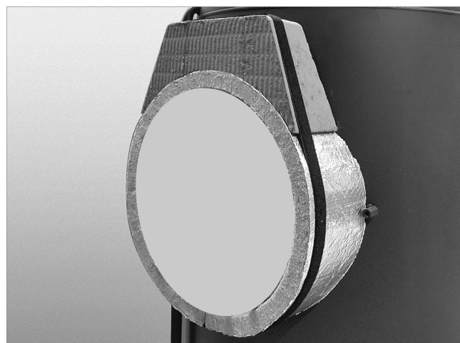
Abb.6: Flanschisolierung fixieren
