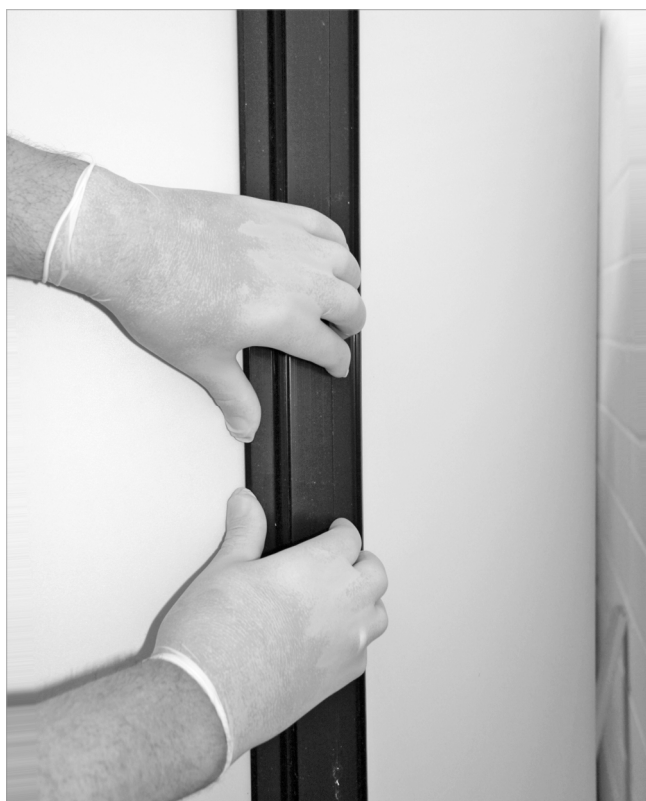
Abb. 49: Isolierung hinten schließen
