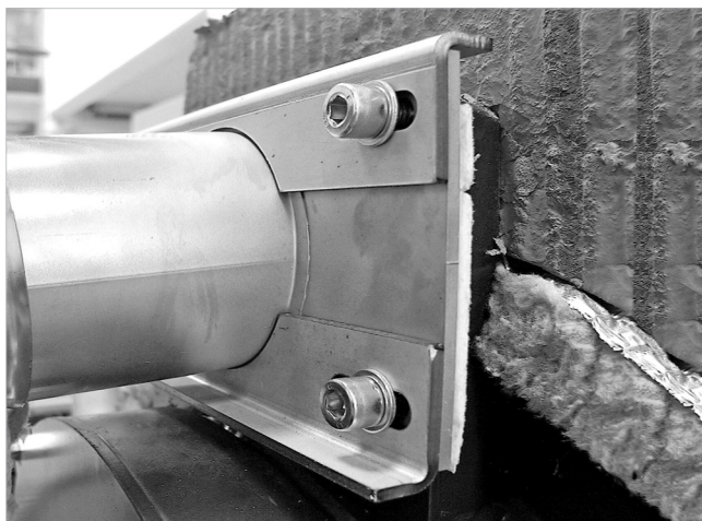
Abb. 17: Abgasanschlussflansch mit Winkelprofilen
