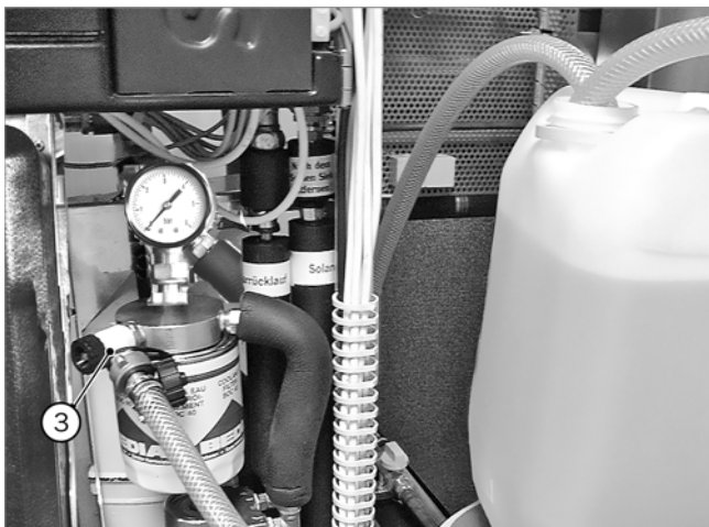
Abb. 62: Füllhahn am Filterdeckel (mit montiertem Solarkreisfilter)
