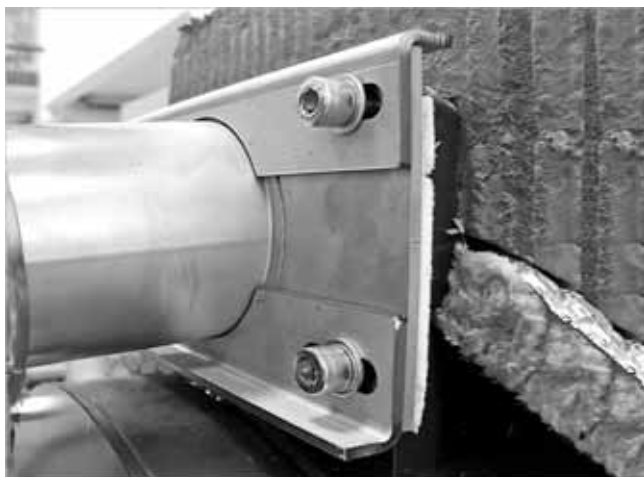
Abb. 17: Abgasanschlussflansch mit Winkelprofilen
