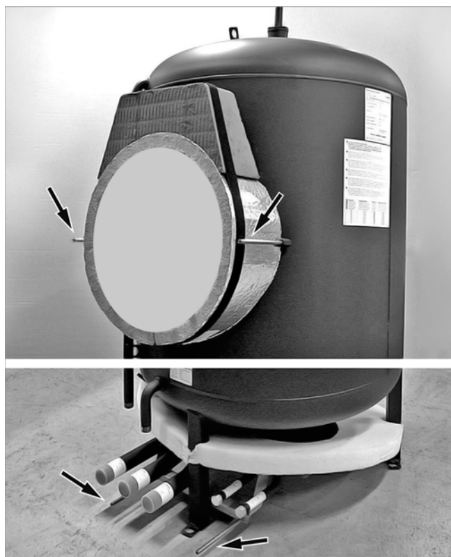
Abb. 7: Konsolenhalterungen montieren
