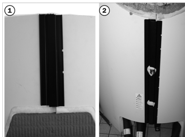
Abb. 48: Isolierung oben (1) und unten (2) schließen
