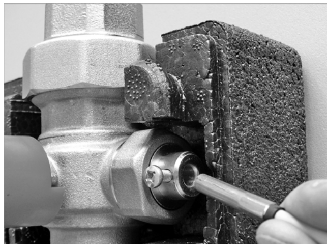
Abb. 42: Vorlauftemperaturfühler montieren
