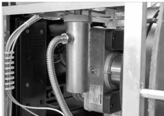
Abb. 26: Siphon mit Kondensatschlauch montieren
