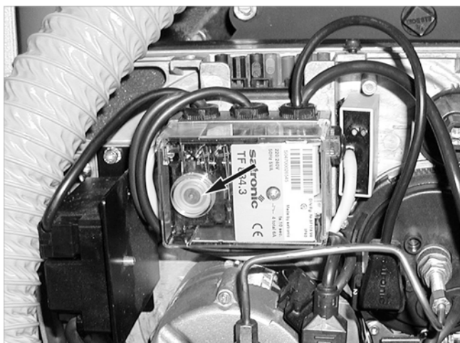
Abb. 75: Feuerungsautomat TF 834
