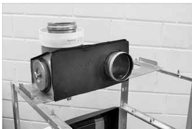
Abb. 16: Konsolenblech mit Abgasanschlusskasten
