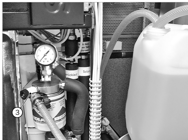
Abb. 41: Füllhahn am Filterdeckel (mit montiertem Solarkreisfilter)
