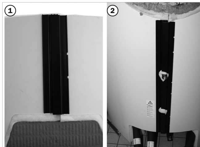
Abb. 32: Isolierung oben (1) und unten (2) schließen
