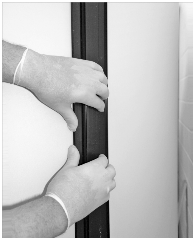
Abb. 33: Isolierung hinten schließen
