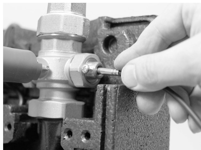
Abb. 26: Vorlauftemperaturfühler montieren
