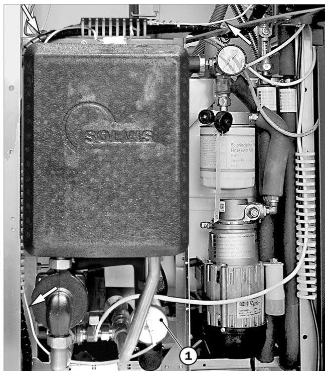
Abb. 21: Leitung VSG-W verlegen
