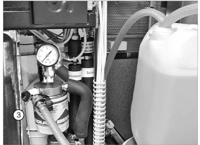
Abb. 41: Füllhahn am Filterdeckel (mit montiertem Solarfilter)
