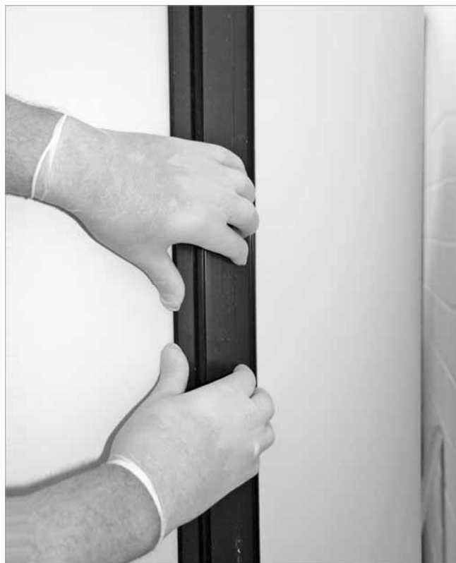
Abb. 33: Isolierung hinten schließen
