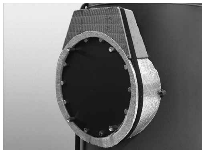
Abb. 6: Flanshisolierung fixieren
