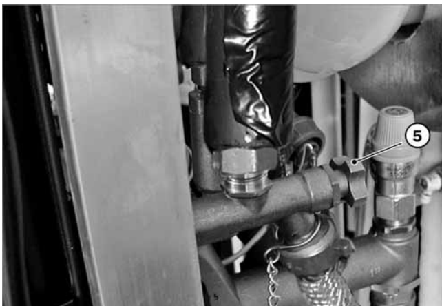
Abb. 40: Spülhahn am Solar-Vorlauf
