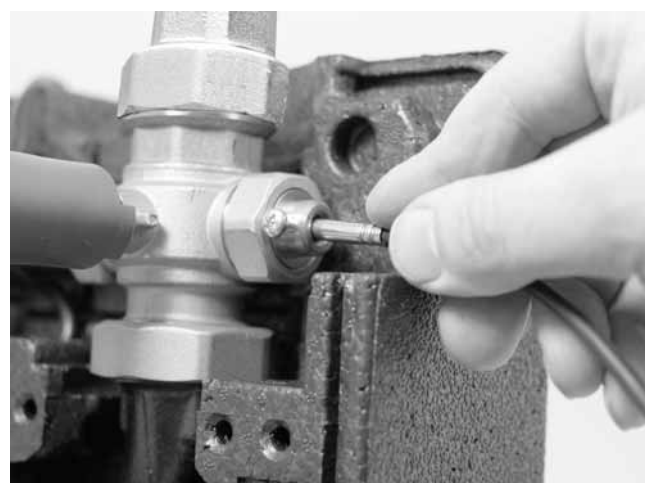
Abb. 26: Vorlauffühler montieren
