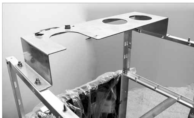
Abb. 10: Konsolenblech montieren
