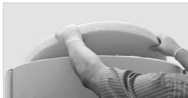
Abb. 35: Deckelrunde auflegen
