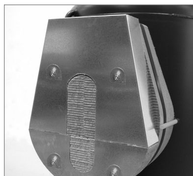
Isolamento da flange
