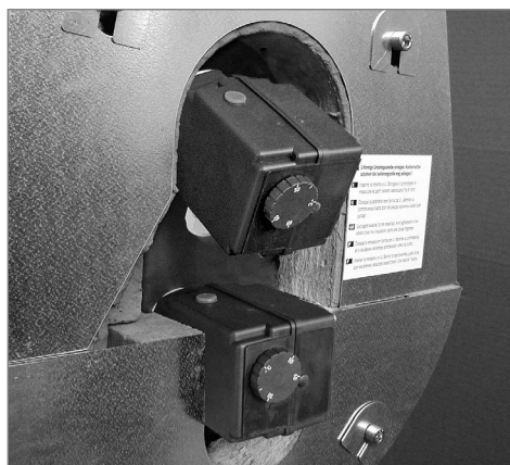
Calentadores eléctricos y aislamiento de brida montados
