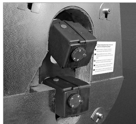
E-Heizstäbe und Flanschisolierung montiert
