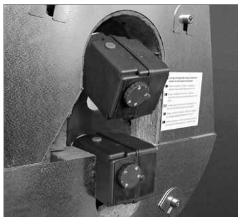
Calentadores eléctricos y aislamiento de brida montados
