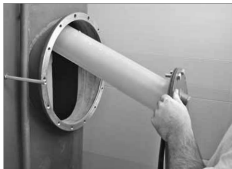
Mise en place du couvercle à bride
