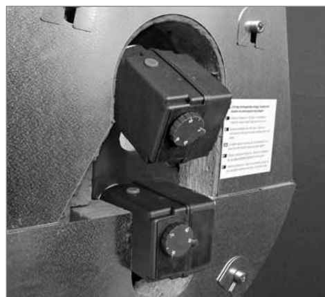
E-Heizstäbe und Flanschisolierung montiert
