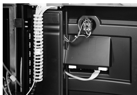
Pose des câbles dans la gaine
