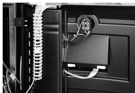
Colocar os cabos no canal
