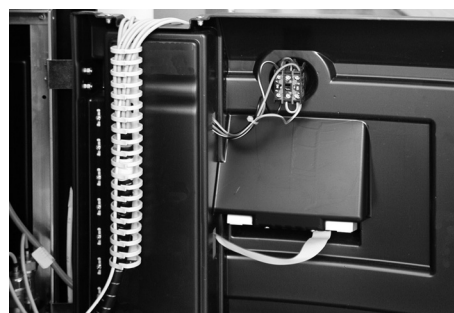
Posa dei cavi nella canalina
