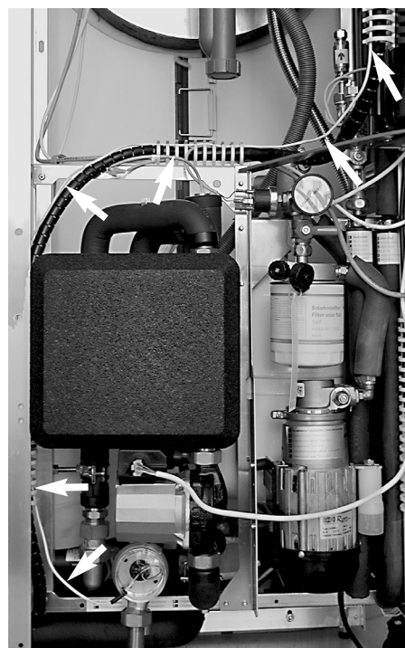
Posa del cavo VSG-W
