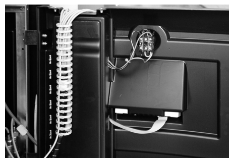
Leitungen in Kabelkanal einlegen
