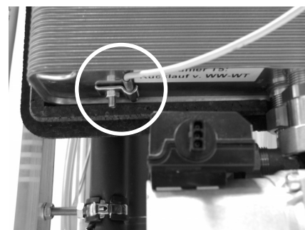
Warmwasser-Rücklauffühler demontieren
