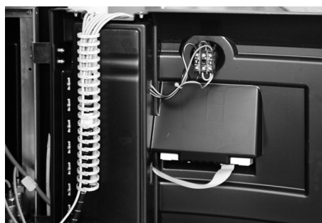
Colocar cables en la canaleta
