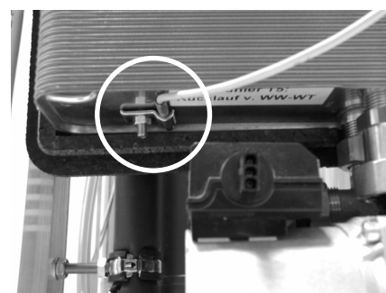
Smontaggio della sonda di ritorno acqua calda
