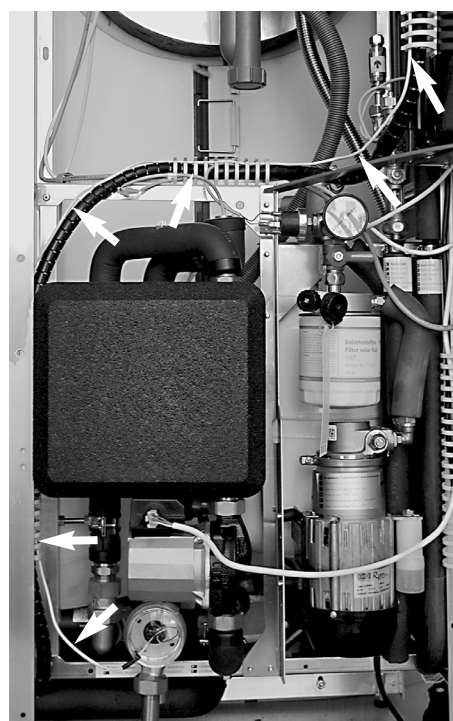
Pose du câble VSG-W
