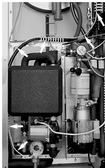
Posa del cavo VSG-W
