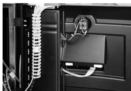
Pose des câbles dans la gaine
