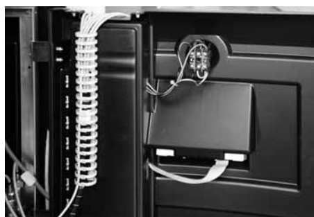
Colocar cables en la canaleta
