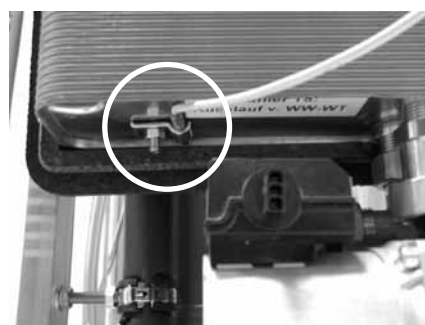
Smontaggio della sonda di ritorno acqua calda
