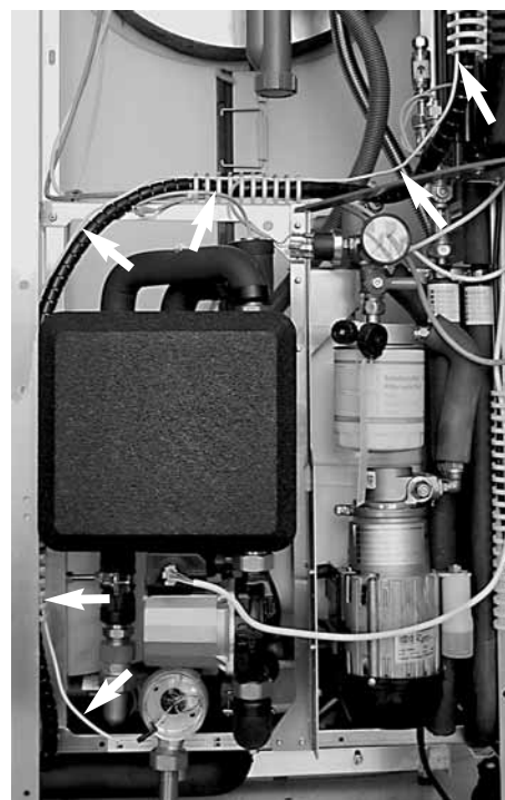
Leitung VSG-W verlegen
