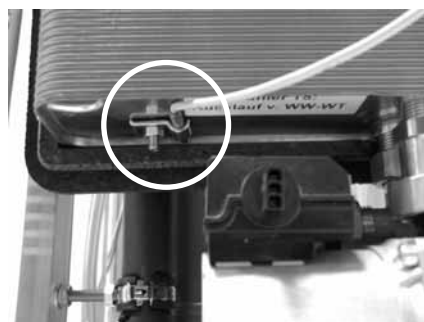
Desmontar o sensor de retorno de AQS
