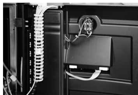
Leitungen in Kabelkanal einlegen
