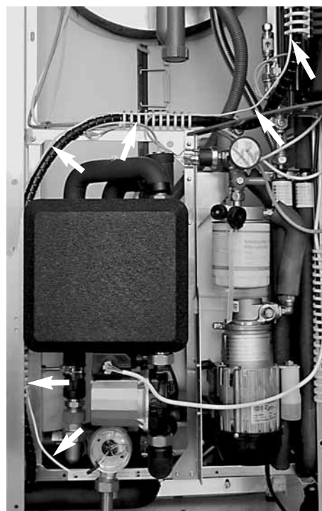
Pose du câble VSG-W
