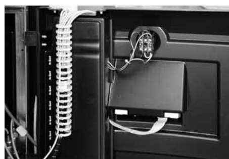
Posa dei cavi nella canalina
