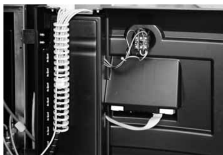
Colocar os cabos no canal
