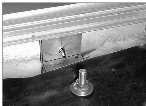
Drittelaufhängung montiert
