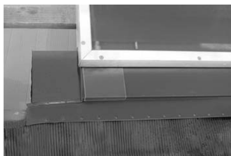
Fig. 153: Inserire il grembiule di sinistra con angolo
