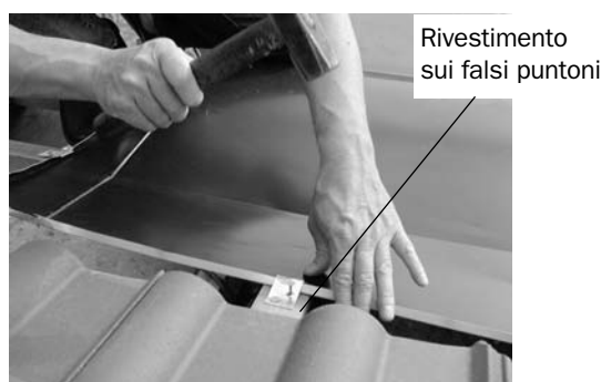
Fig. 186: Fissare la lamiera superiore sul lato superiore del collettore
