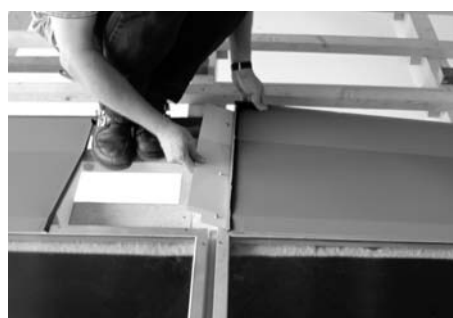
Fig. 181: Montare la parte inferiore della connessione lamiera superiore con l'aletta e la lamiera di sinistra
