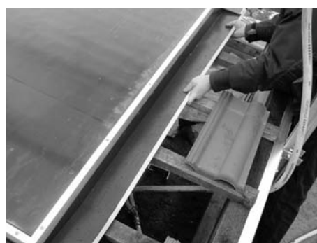
Fig. 59: Inserire le lamiere laterali e posizionarle sull'angolo del grembiule
