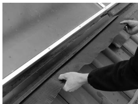
Fig. 145: Inserire gli ulteriori grembiuli
