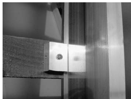
Fig. 41: Posizionare il profilato a U
