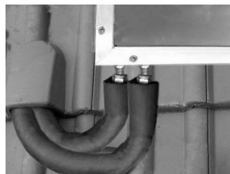
Fig. 198: Collegamento con isolante
