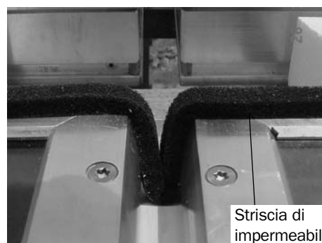
Fig. 162: Applicare il giunto a V
