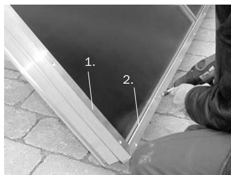
Fig. 193: Montare il profilato a clip ai bordi
