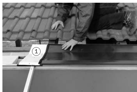
Fig. 179: Inserire la parte inferiore del collegamento tra lamiere superiori (1) e l'angolo della lamiera superiore destra
