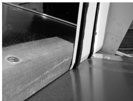
Fig. 106: Inserire la parte superiore dell'angolo lamiera intermedia
