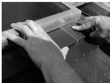
Fig. 144: Premere ed allineare fissaggi ed angoli
