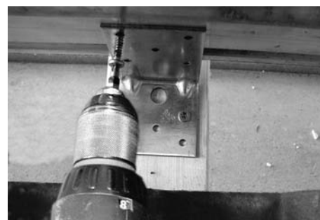
Fig. 129: Avvitare la staffa inferiore con il collettore
