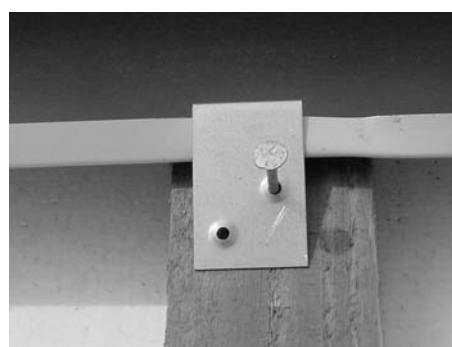
Fig. 29: Fissare le lamiere laterali e superiori ai lati destro e sinistro del collettore
