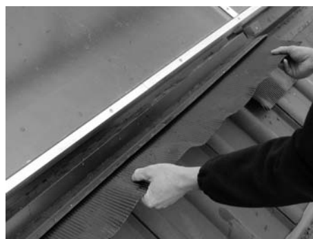
Fig. 92: Inserire gli ulteriori grembiuli
