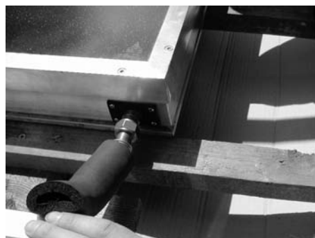
Fig. 210: Inserire e serrare il collegamento inferiore
