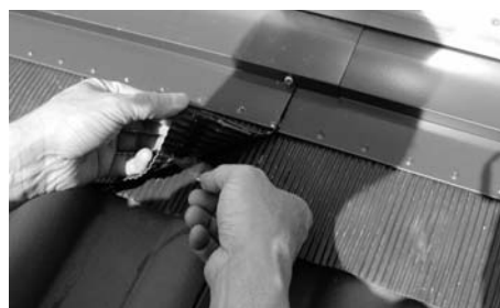
Fig. 156: Togliere le strisce protettive e premere con forza i grembiuli
