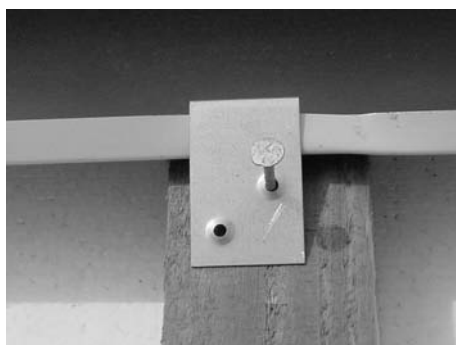
Fig. 185: Fissare le lamiere laterali e superiori ai lati destro e sinistro del collettore
