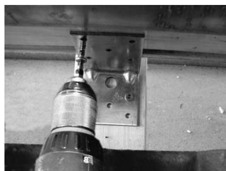
Fig. 82: Avvitare la staffa inferiore con il collettore
