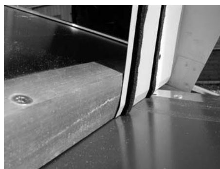
Fig. 167: Inserire la parte superiore dell'angolo lamiera intermedia
