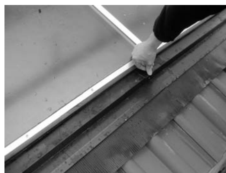
Fig. 17: Allineare grembiuli e fissaggi
