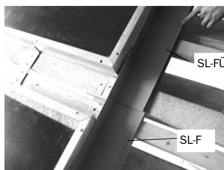
Fig. 99: Montare la lamiera laterale superiore SL-FÜ
