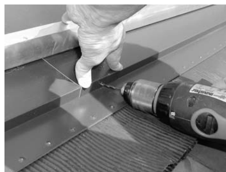
Fig. 18: Premere, forare ed avvitare i fissaggi
