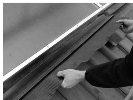
Fig. 47: Inserire gli ulteriori grembiuli
