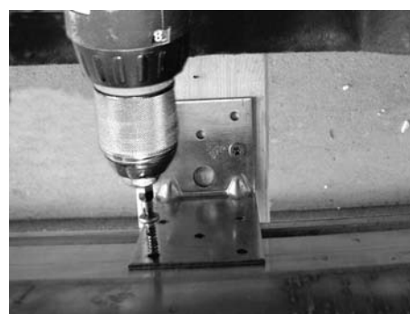
Fig. 87: Fissaggio superiore del collettore
