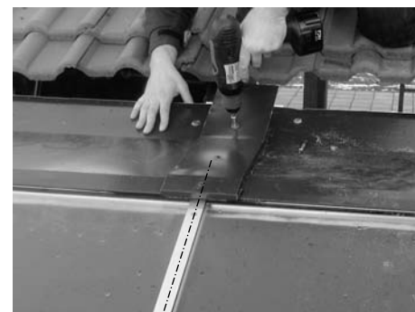
Fig. 116: Posizionare, allineare ed avvitare il collegamento tra lamiere superiori
