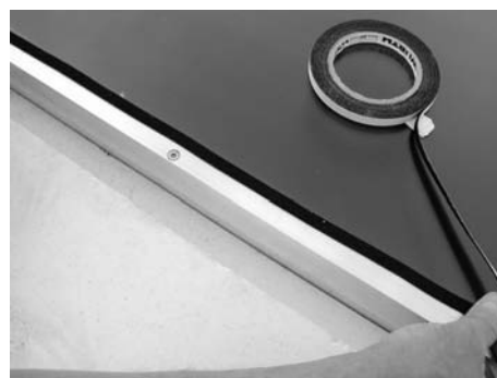
Fig. 23: Incollare una striscia di impermeabilizzazione continua
