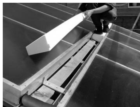
Fig. 100: Inserire i puntelli intermedi
