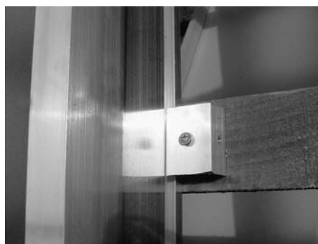
Fig. 139: Applicare due profilati a U
