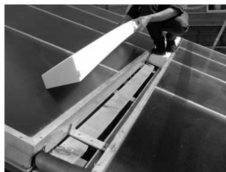
Fig. 160: Inserire i puntelli intermedi
