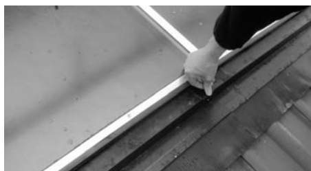
Fig. 56: Allineare grembiuli e fissaggi.
