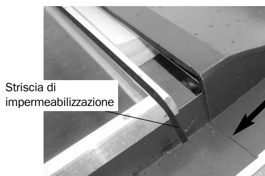
Fig. 178: Inserire l'angolo della lamiera superiore destra
