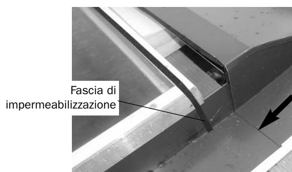
Fig. 24: Inserire l'angolo della lamiera superiore destra
