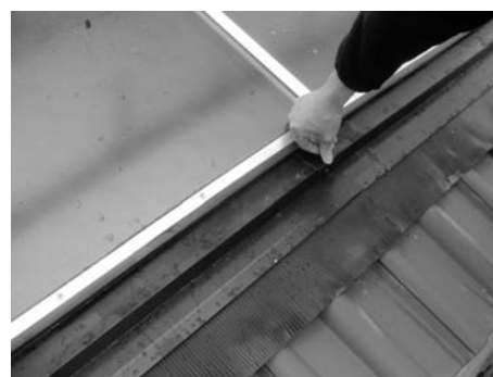
Fig. 94: Allineare grembiuli e fissaggi
