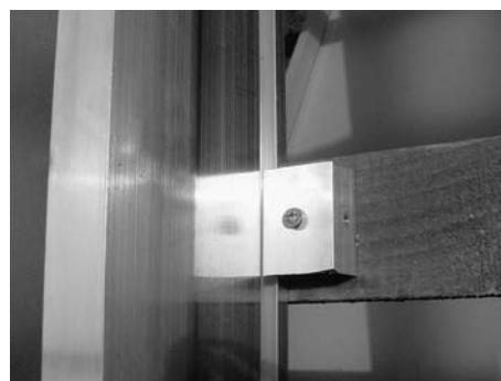
Fig. 130: Posizionare due profilati a U
