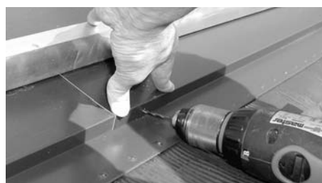
Fig. 155: Premere, forare ed avvitare i fissaggi per grembiuli
