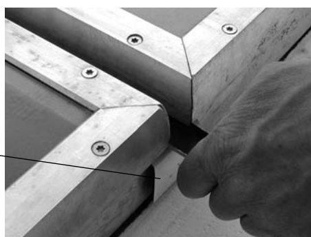
Fig. 53: Lamiera di arresto per parte centrale verticale (HVM) montata
