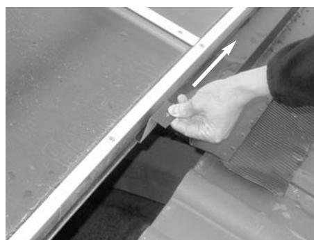
Fig. 45: Inserire due fissaggi per grembiule
