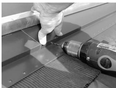
Fig. 57: Premere, forare ed avvitare i fissaggi per grembiuli
