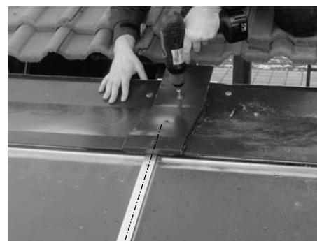
Fig. 65: Posizionare, allineare ed avvitare la seconda lamiera superiore ed il collegamento
