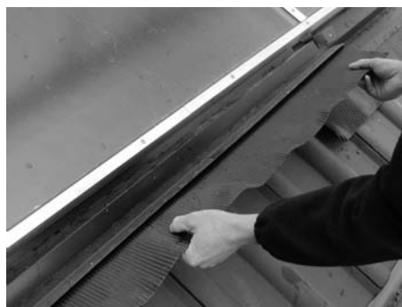
Fig. 54: Inserire ulteriori grembiuli
