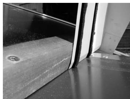
Fig. 167: Inserire la parte superiore dell'angolo lamiera intermedia
