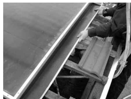
Fig. 20: Inserire le lamiera laterali e posizionarle sopra gli angoli dei grembiuli
