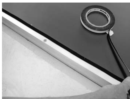
Fig. 111: Incollare una striscia di impermeabilizzazione continua
