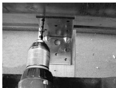
Fig. 82: Avvitare la staffa inferiore con il collettore
