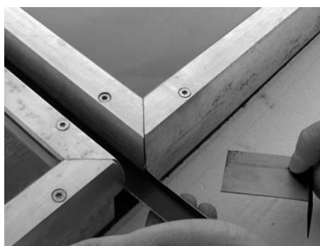
Fig. 170: Inserire il fermo per componente centrale verticale (HVM)
