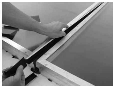
Fig. 48: Posizionare la guida centrale verticale
