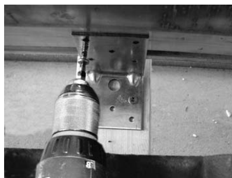
Fig. 133: Avvitare il collettore con la staffa a L inferiore
