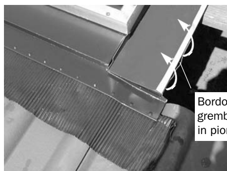
Fig. 158: Piegar il bordo del grembiule su quello della lamiera laterale
