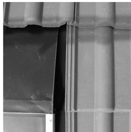
Fig. 74: Ricoprire i lati del collettore con le tegole
