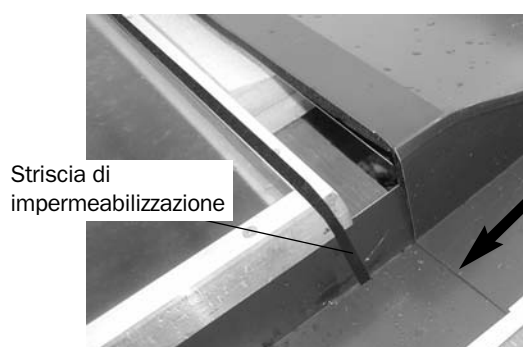
Fig. 178: Inserire l'angolo della lamiera superiore destra
