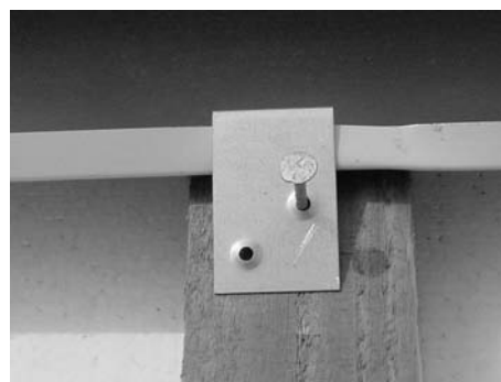
Fig. 69: Fissare le lamiere laterali e superiori a destra e a sinistra del collettore
