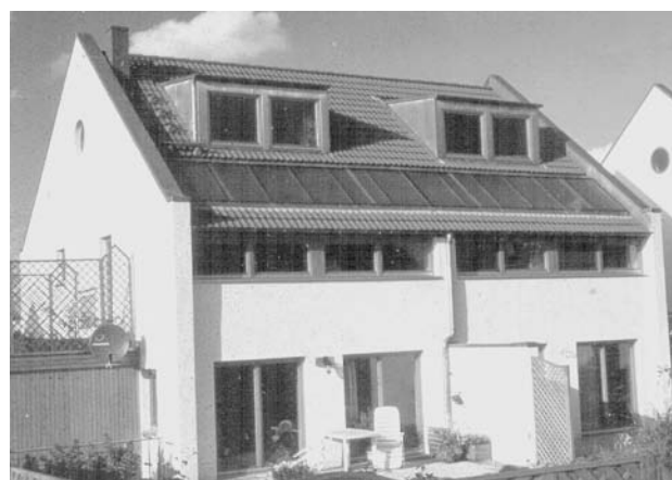
Fig. 35: Montaggio affiancato integrato nel tetto
