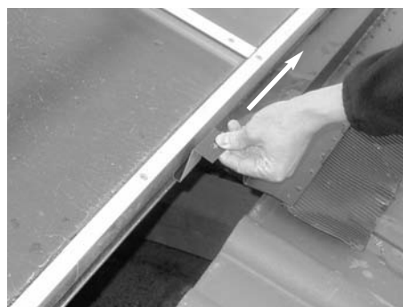
Fig. 90: Inserire il grembiule a destra con l'angolo
