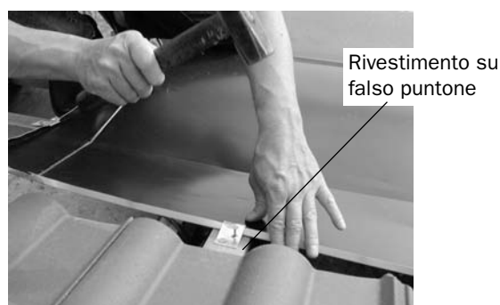
Fig. 30: Fissare la lamiera superiore sul lato superiore del collettore
