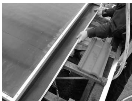
Fig. 157: Inserire le lamiere laterali e posizionarle sull'angolo del grembiule
