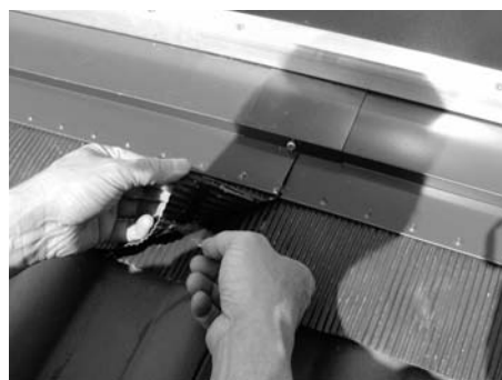
Fig. 96: Togliere le strisce protettive e premere con forza i grembiuli
