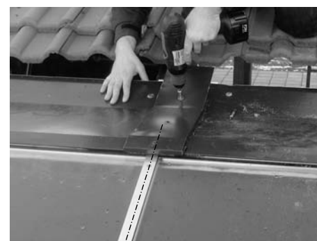
Fig. 116: Posizionare, allineare ed avvitare il collegamento tra lamiere superiori
