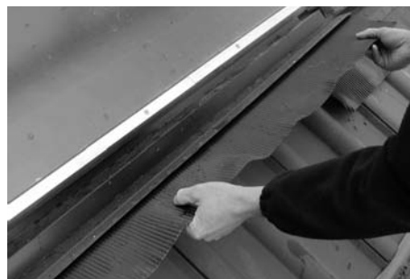
Fig. 152: Inserire ulteriori grembiuli
