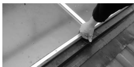
Fig. 154: Allineare grembiuli e fissaggi
