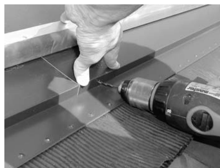
Fig. 18: Premere, forare ed avvitare i fissaggi
