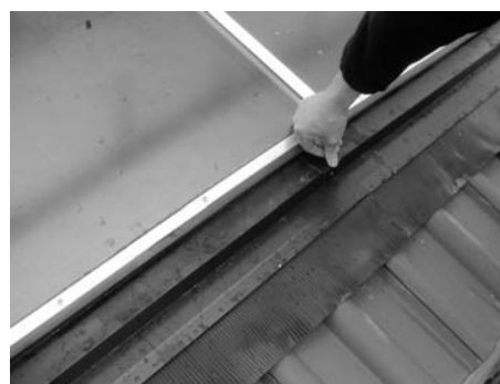
Fig. 17: Allineare grembiuli e fissaggi
