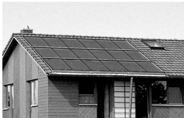
Fig. 75: Montaggio sovrapposto integrato nel tetto
