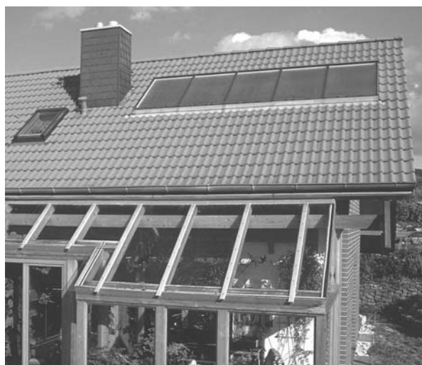
Fig. 5: Montaggio integrato nel tetto
