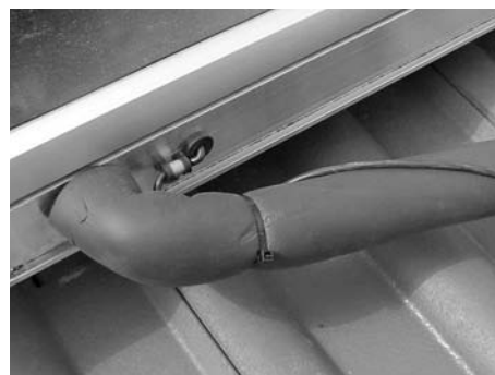
Fig. 226: Posare il cavo della sonda
