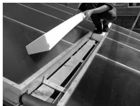
Fig. 160: Inserire i puntelli intermedi
