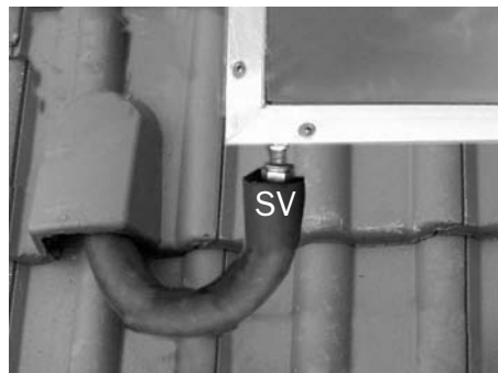
Fig. 221: Collegamento (mandata solare) con isolamento
