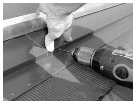
Fig. 95: Premere, forare ed avvitare i fissaggi per grembiuli
