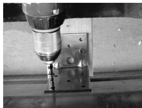
Fig. 138: Fissaggio superiore del collettore
