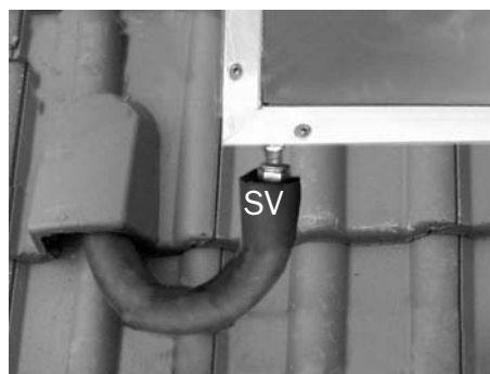
Fig. 217: Collegamento (mandata solare) con isolamento
