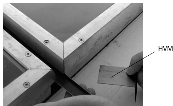
Fig. 52: Inserire la lamiera di arresto per la parte centrale verticale (HVM)
