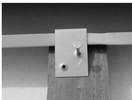
Fig. 117: Fissare le lamiere laterali e superiori ai lati destro e sinistro del collettore
