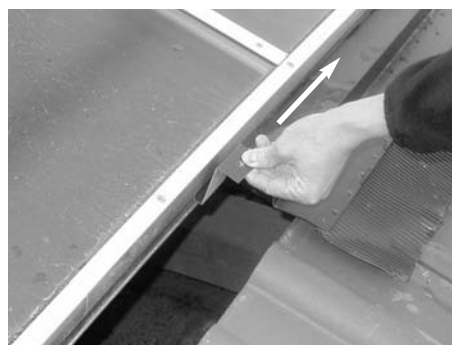
Fig. 143: Inserire due fissaggi per grembiule
