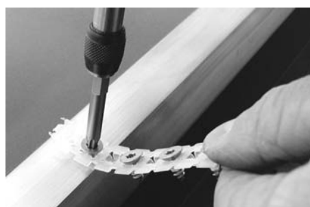
Fig. 194: Inserire le viti Torx
