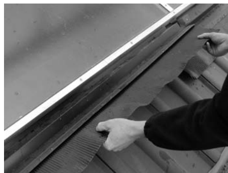
Fig. 47: Inserire gli ulteriori grembiuli
