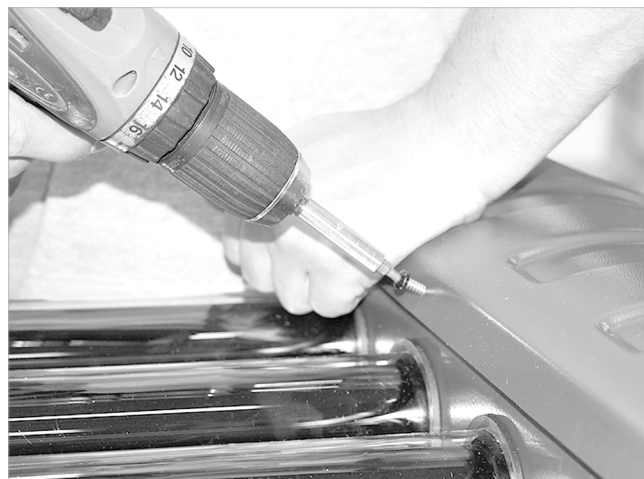
Abb. 2: Gehäusedeckel festschrauben
