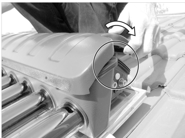
Abb. 1: Gehäusedeckel von schräg oben einsetzen
