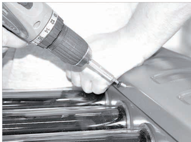
Abb. 2: Gehäusedeckel festschrauben
