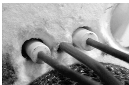
Nach dem Ausschneiden, mit eingesetzter Zündelectrode
