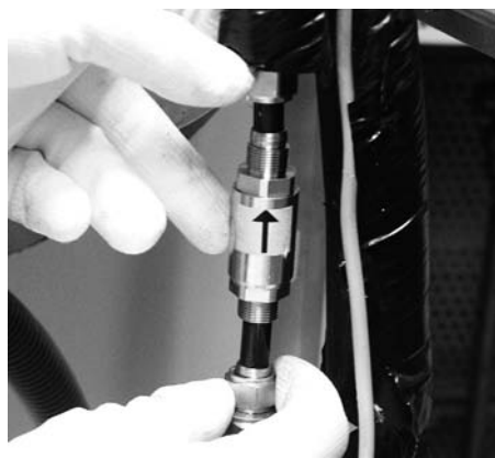
Colocar a válvula de retenção
