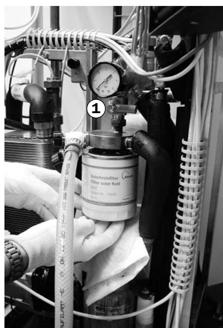
Filtro per il circuito solare Art. 13026
