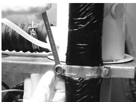
Abrazadera de fijación del conducto solar
