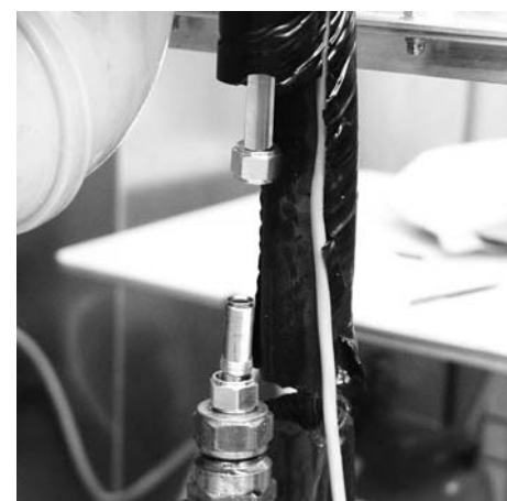
Manguitos de apoyo y atornilladuras de anillos de apriete
