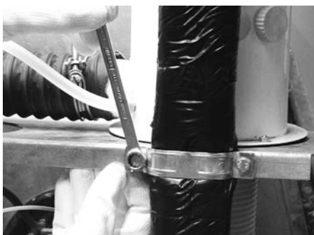
Fascetta di attacco della conduzione solare
