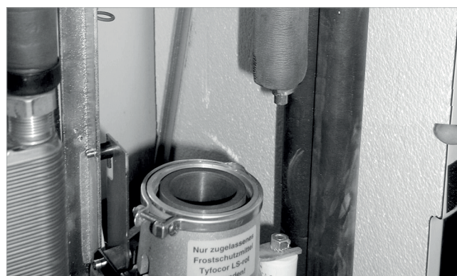
Abb. 37: Pumpenkopf abgenommen
