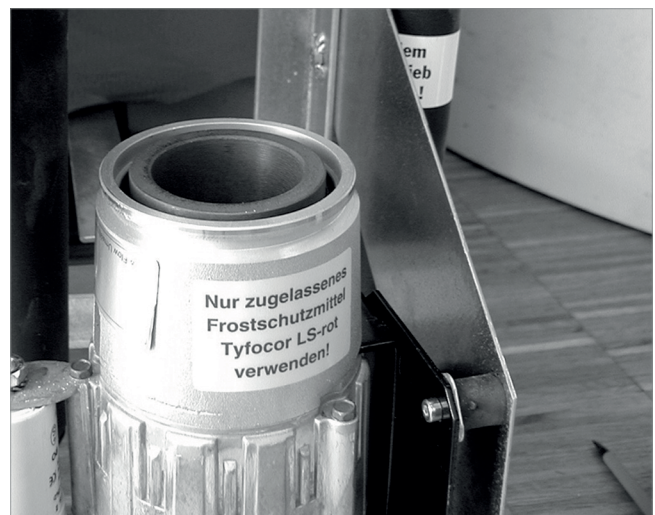
Abb. 16: Pumpenkopf und Wellrohre abgenommen
