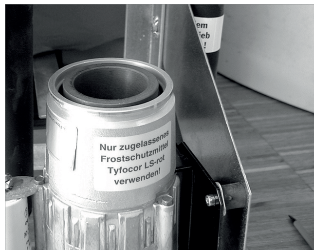
Abb. 4: Pumpenkopf und Wellrohre abgenommen
