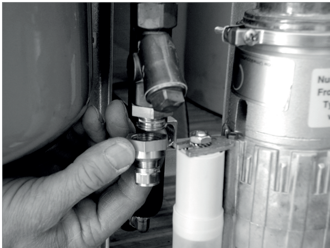
Abb. 23: Reduzierstück am Schmutzfänger montieren
