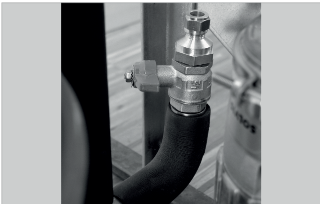
Abb. 11: Reduzierstück am Kugelhahn montieren
