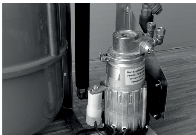
Abb. 2: Flügelzellenpumpe montiert
