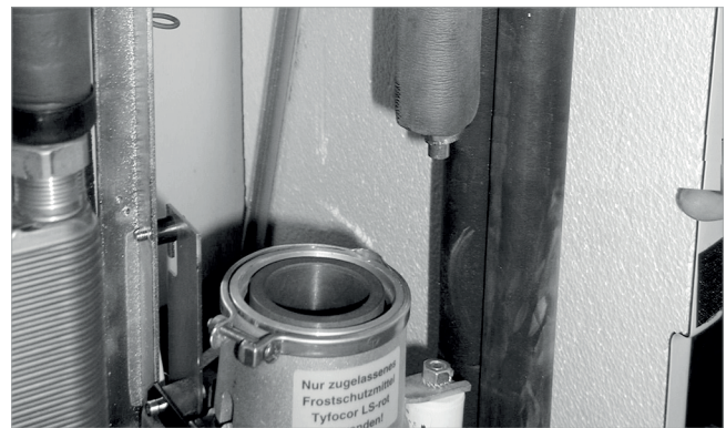
Abb. 32: Pumpenkopf abgenommen
