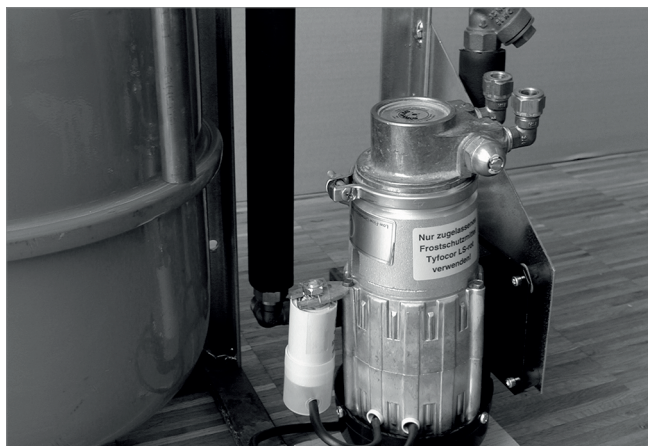
Abb. 5: Neuer Pumpenkopf um 90° gedreht eingesetzt
