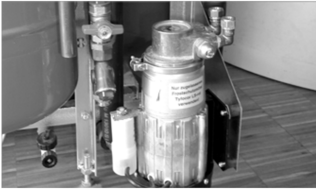
Abb. 17: Neuer Pumpenkopf um 90° gedreht eingesetzt
