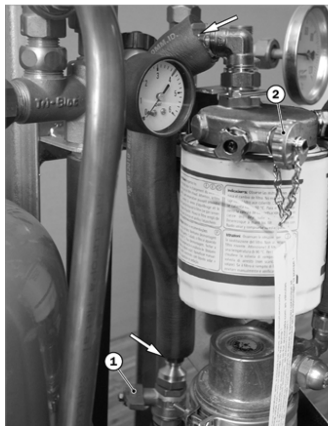
Abb. 12: Langes Rohr hinter dem Filter montieren
