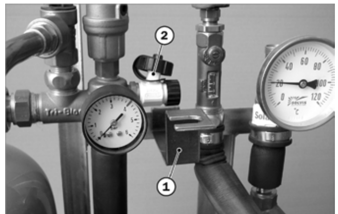
Abb. 20: Filterhalterung einhängen
