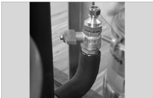
Abb. 11: Reduzierstück am Kugelhahn montieren
