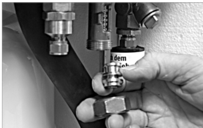
Abb. 29: Reduzierstück am Abgleichventil einsetzen
