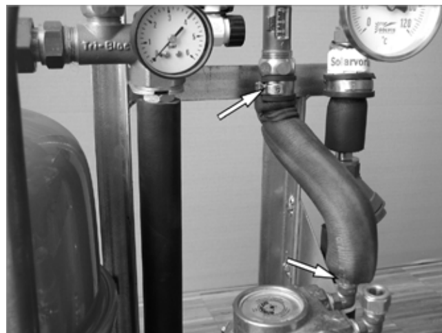
Abb. 7: Rohr an Pumpe (Druckseite) montieren
