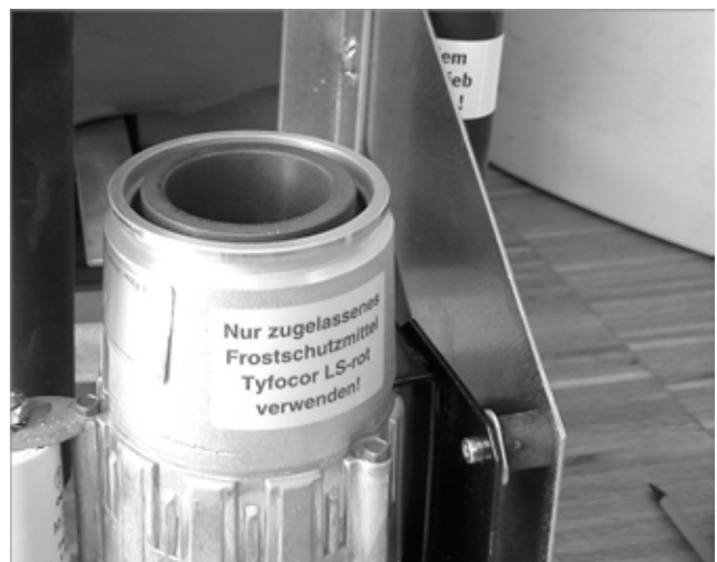
Abb. 16: Pumpenkopf und Wellrohre abgenommen
