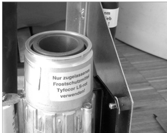
Abb. 4: Pumpenkopf und Wellrohre abgenommen
