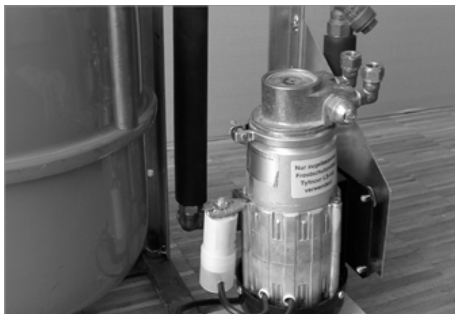
Abb. 5: Neuer Pumpenkopf um 90° gedreht eingesetzt
