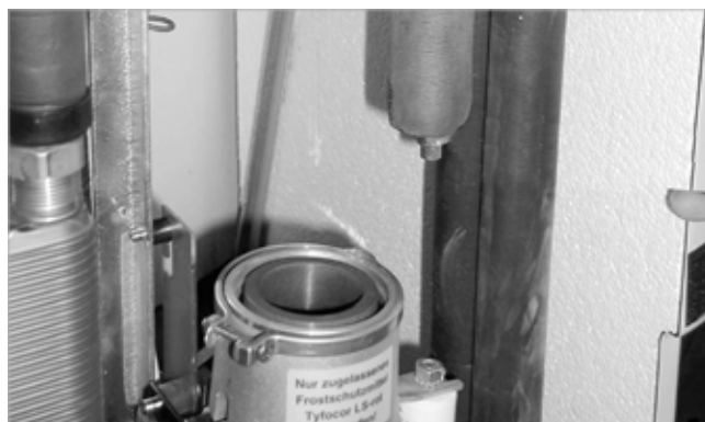
Abb. 32: Pumpenkopf abgenommen
