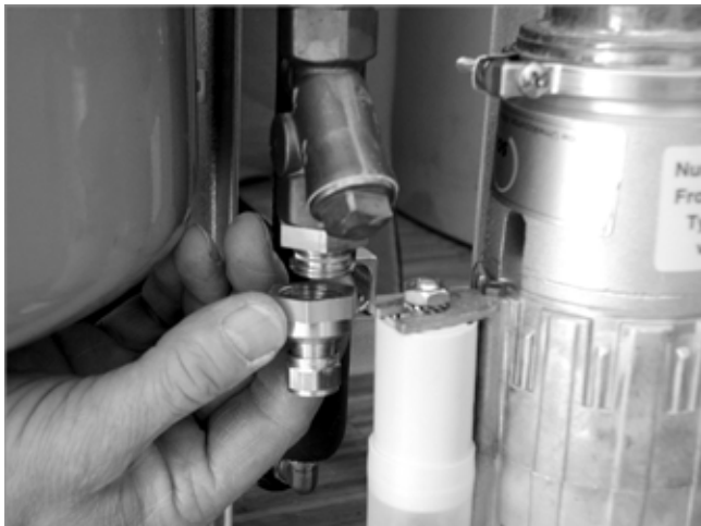
Abb. 23: Reduzierstück am Schmutzfänger montieren
