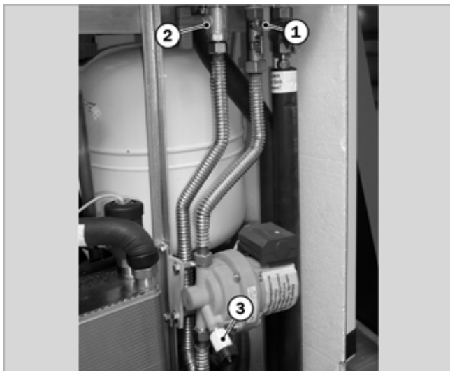
Abb. 25: Zahnradpumpe mit Wellrohren
