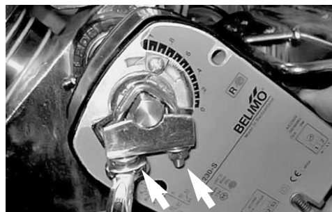
Muttern des Klemmbügels lösen
