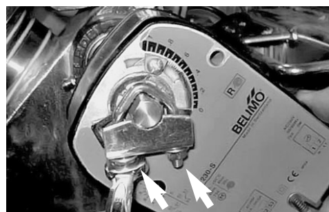
Muttern des Klemmbügels lösen
