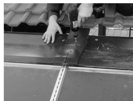
Zweites Oberblech und Oberblechverbinder auflegen, ausrichten und verschrauben
