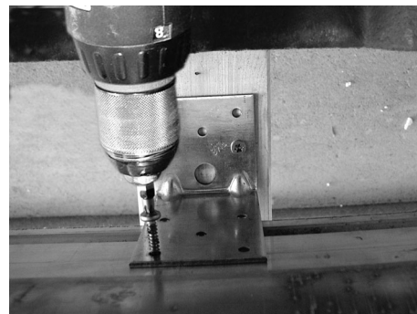
Befestigen des Kollektors oben
