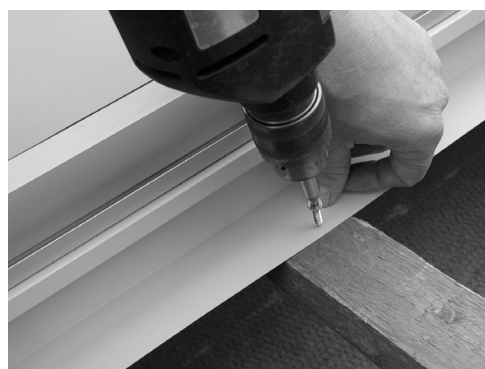
Verbindungsblech verschrauben
