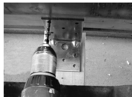
Untere Winkel mit dem Kollektor verschrauben
