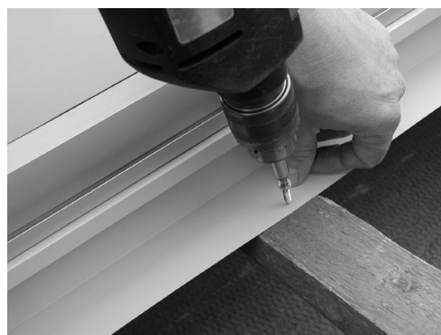
Verbindungsblech verschrauben
