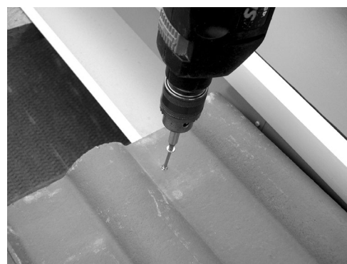
Ziegel an der Latte neben dem Seitenblech befestigen
