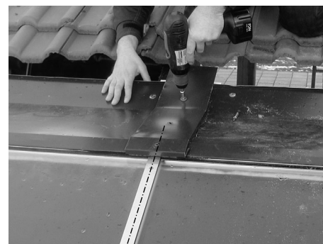
Zweites Oberblech und Oberblechverbinder auflegen, ausrichten und verschrauben
