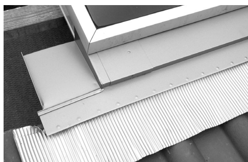
Linke Bleischürze (mit Ecke) eingelegt
