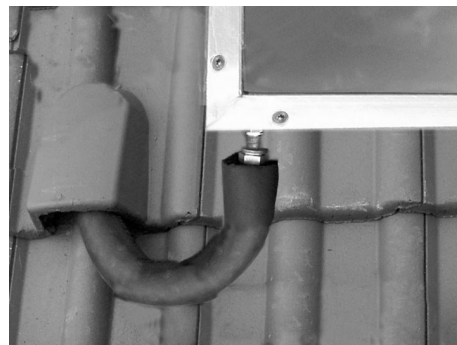
flexibler Anschluss für Solarvor- und rücklauf
