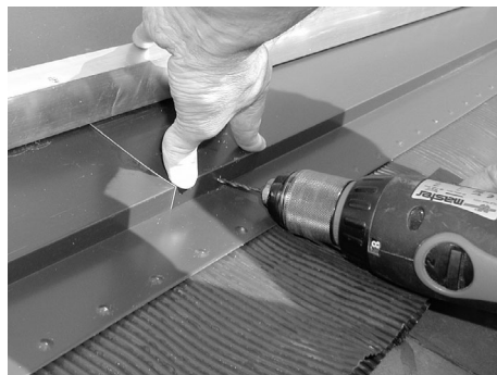
Bleischürzenfixierung andrücken, vorbohren und verschrauben
