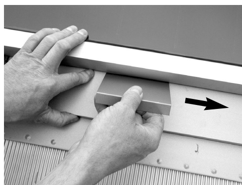
Bleischürzenfixierung einsetzen und nach rechts schieben
