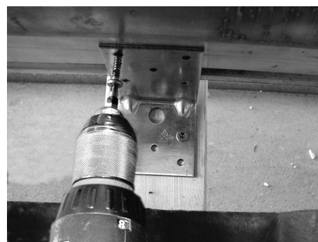
Obere Winkel montieren, alle Winkel mit dem Kollektor verschrauben
