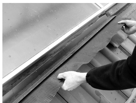
Weitere Bleischürzen einsetzen
