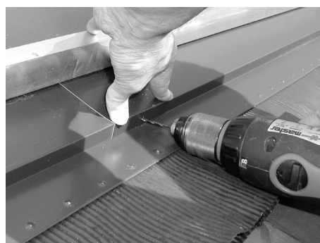
Bleischürzenfixierung andrücken, vorbohren und verschrauben
