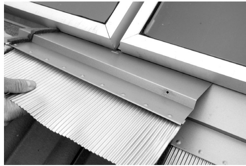
Bleischürzen-Mittelverbinder (BSM) einsetzen
