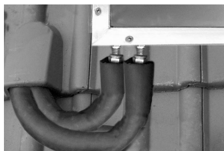
Flexibler Anschluss mit Isolierung
