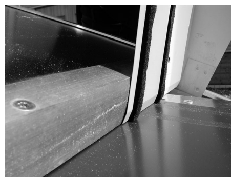
Zwischenblechecke einsetzen
