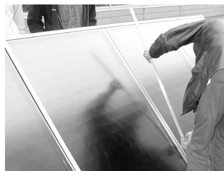
Als letztes Querträgerabdeckleisten montieren
