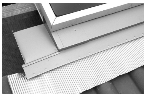
Linke Bleischürze (mit Ecke) eingelegt
