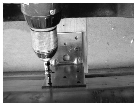
Befestigen des Kollektors oben
