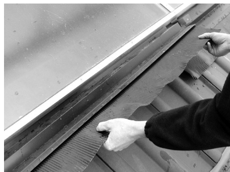
Weitere Bleischürzen einsetzen
