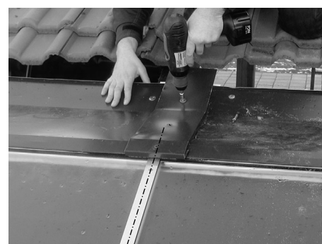
Zweites Oberblech und Oberblechverbinder auflegen, ausrichten + verschrauben
