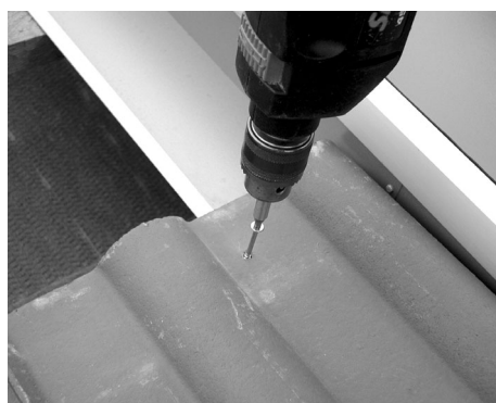
Ziegel an der Latte neben dem Seitenblech befestigen
