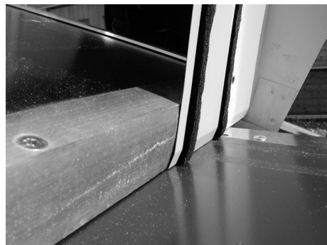
Oberteil Zwischenblechecke einsetzen
