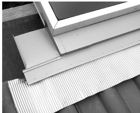
Linke Bleischürze (mit Ecke) eingelegt
