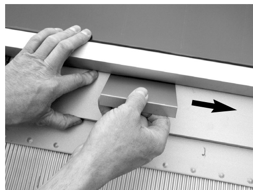
Bleischürzenfixierung einsetzen und nach rechts schieben
