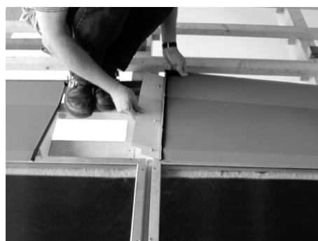
Unterteil vom Oberblechverbinder mit Nase und linkes Oberblech montieren
