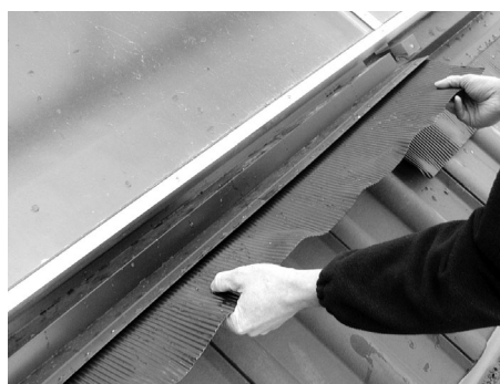
Mittlere Bleischürze einsetzen
