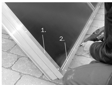
Clip-Profile an den Rändern montieren
