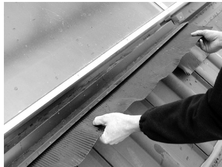
Mittlere Bleischürze einsetzen
