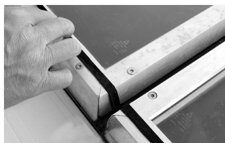
An jedem Kollektor Fugendichtband durchgehend aufkleben
