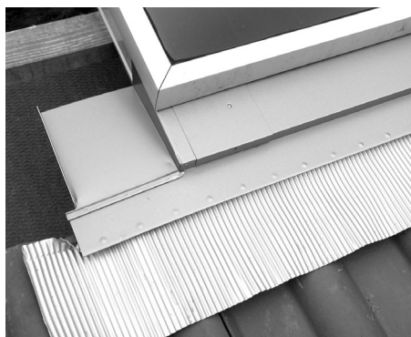
Linke Bleischürze (mit Ecke) eingelegt
