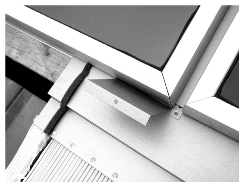
Zweite Bleischürzenfixierung einsetzen
