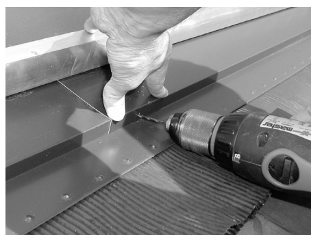
Bleischürzenfixierung andrücken, vorbohren und verschrauben
