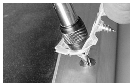
Gurt über Torx-Schraube ziehen und Schraube eindrehen
