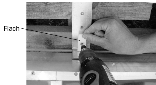
Befestigung des Kollektors oben
