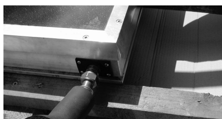
Kollektorverbinder KV-F-Ü am oberen Kollektor verschraubt
