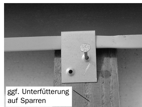
ggf. Unterfütterung auf Sparren Seiten- und Oberbleche fixieren
