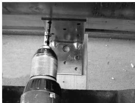
Kollektor mit unteren Winkeln verschrauben
