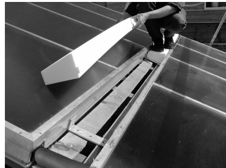
Zwischenblechstützen auflegen
