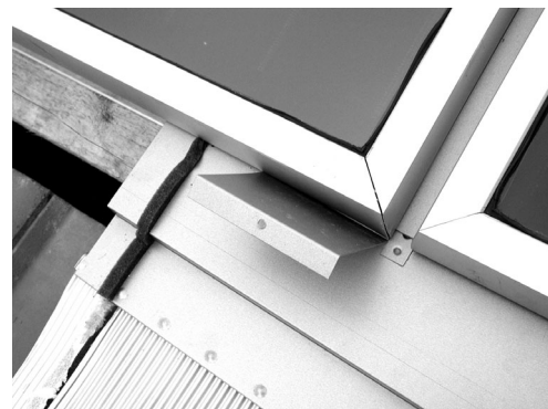
Zweite Bleischürzenfixierung einsetzen
