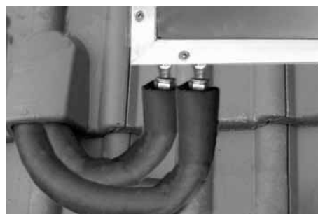
Flexibler Anschluss mit Isolierung
