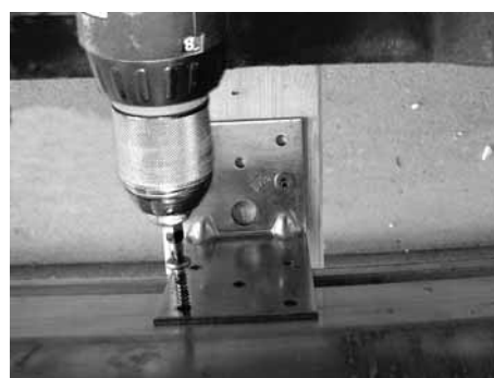
Befestigen des Kollektors oben
