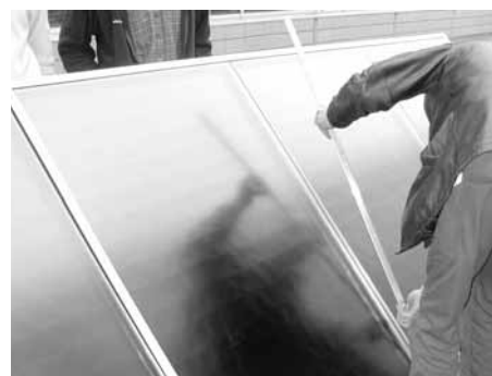
Als letztes Querträgerabdeckleisten montieren
