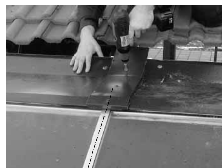
Zweites Oberblech und Oberblechverbinder auflegen, ausrichten + verschrauben
