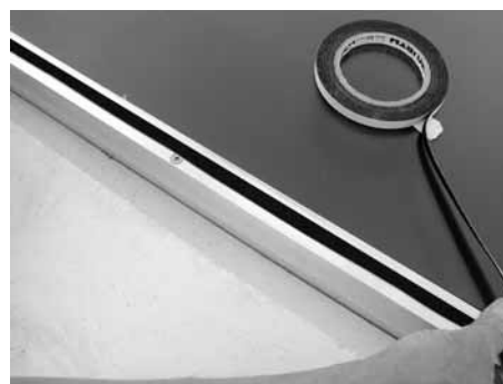
Fugendichtband mittig auf dem Profil durchgehend aufkleben
