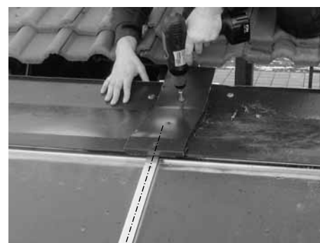
Oberblechverbinder auflegen, ausrichten und verschrauben
