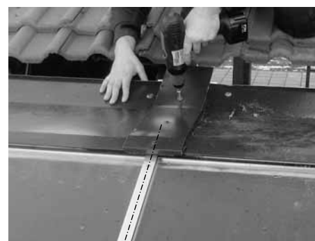
Oberblechverbinder auflegen, ausrichten und verschrauben
