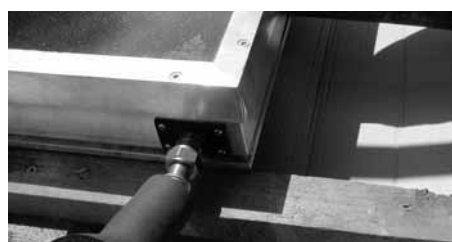
Kollektorverbinder KV-F-Ü am oberen Kollektor verschraubt
