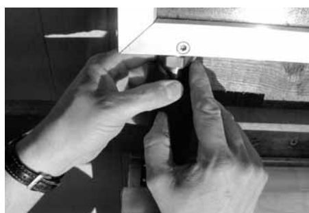
Kollektorverbinder KV-F-Ü am unteren Kollektor verschraubt
