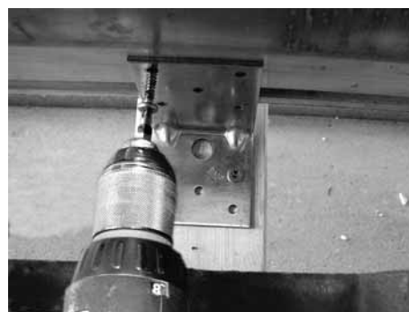
Kollektor ausrichten, obere Winkel montieren, alle Winkel mit dem Kollektor verschrauben
