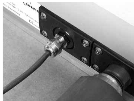
Fühler bis zum Anschlag eingesteckt und verschraubt
