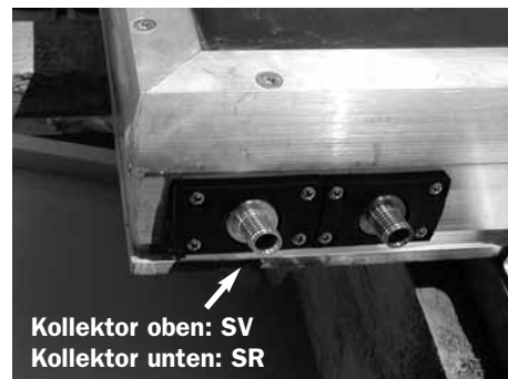
Anschluss Vorlauf (SV) und Rücklauf (SR) je nach Kollektor verschieden
