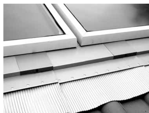
Nächste Bleischürze eingelegt, Fixierungen positioniert
