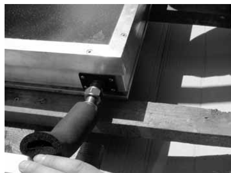
Kollektorverbinder KV-F-Ü am unteren Kollektor verschraubt
