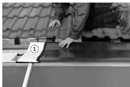
Unterteil des Oberblechverbinders (1) und rechte Oberblechecke einfügen
