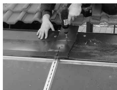
2. Oberblech und Oberblechverbinder auflegen, ausrichten und verschrauben
