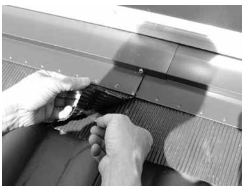
Schutzstreifen abziehen und Bleischürzen fest andrücken
