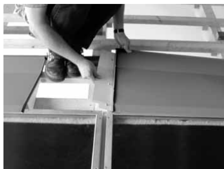
Unterteil vom Oberblechverbinder mit Nase und linkes Oberblech montieren
