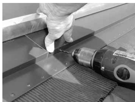
Bleischürzenfixierung andrücken, vorbohren und verschrauben
