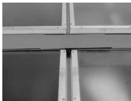
Kreuzstoß fertig montiert
