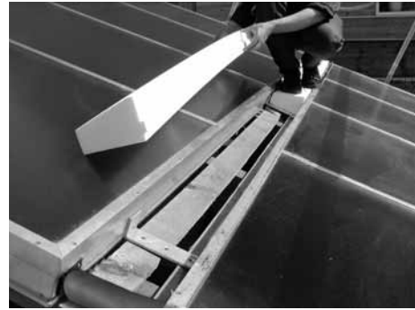
Zwischenblechstützen auflegen
