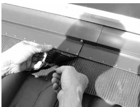
Schutzstreifen abziehen und Bleischürzen fest andrücken
