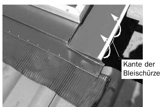
Bleischürzenkante über Seitenblechkante biegen
