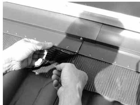
Schutzstreifen abziehen und Bleischürzen fest andrücken
