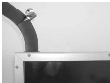
flexibler Anschluss mit SFE-Hahn für Solarvor- und rücklauf
