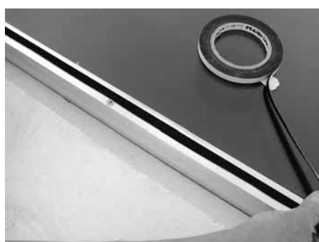
Auf unterem Kollektor Fugendichtband mittig auf dem Profil durchgehend aufkleben
