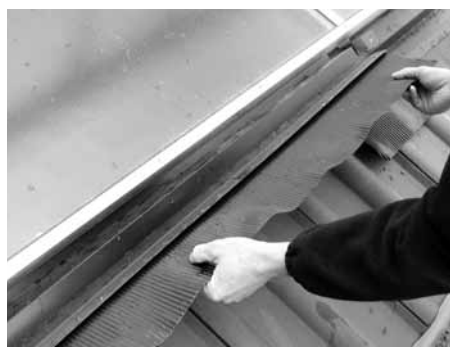
Mittlere Bleischürze einsetzen
