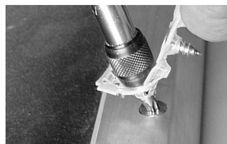
Gurt über Torx-Schraube ziehen und Schraube eindrehen
