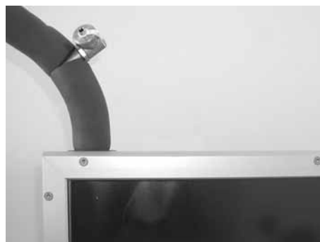
flexibler Anschluss mit SFE-Hahn für Solarvor- und rücklauf
