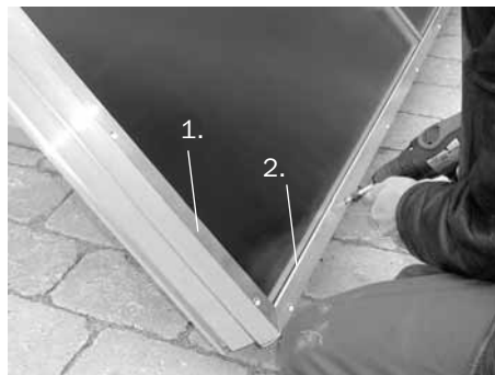
Clip-Profile an den Rändern montieren
