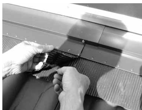
Schutzstreifen abziehen und Bleischürzen fest andrücken
