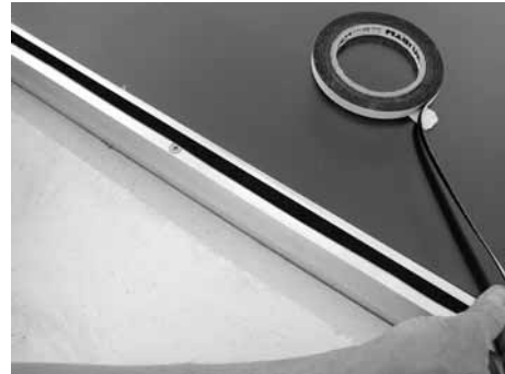
Fugendichtband mittig auf dem Profil durchgehend aufkleben
