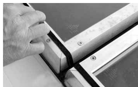
An jedem Kollektor Fugendichtband durchgehend aufkleben
