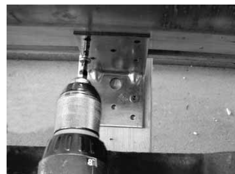
Untere Winkel mit dem Kollektor verschrauben
