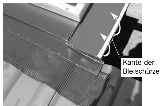
Bleischürzenkante über Seitenblechkante biegen
