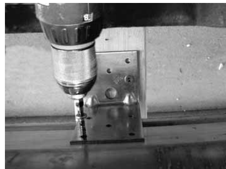
Befestigen des Kollektors oben
