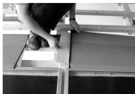
Unterteil vom Oberblechverbinder mit Nase und linkes Oberblech montieren
