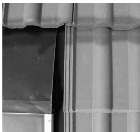
Eindeckung oben und seitlich
