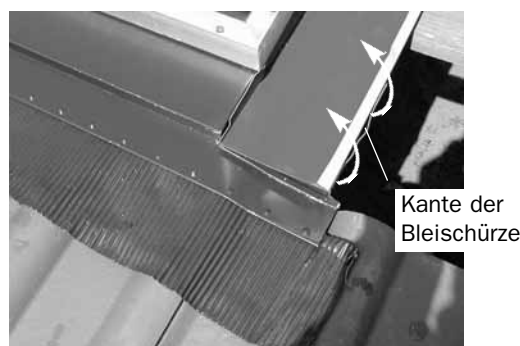
Bleischürzenkante über Seitenblechkante biegen
