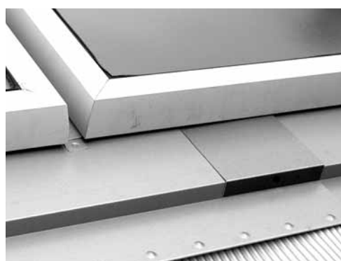
Bleischürzenfixierung zurückgeschoben und positioniert
