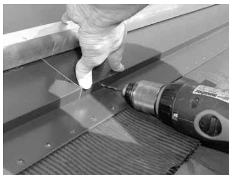
Bleischürzenfixierung andrücken, vorbohren und verschrauben
