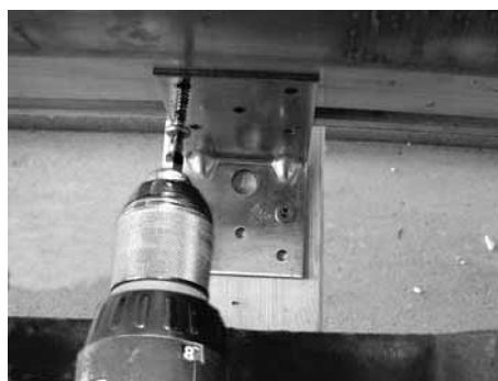
Kollektor mit unteren Winkeln verschrauben
