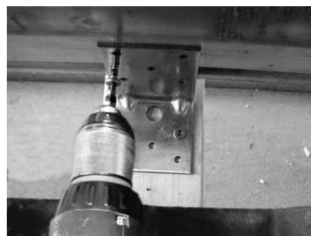
Obere Winkel montieren, alle Winkel mit dem Kollektor verschrauben
