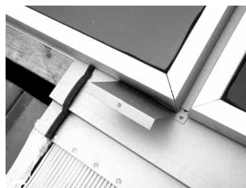
Zweite Bleischürzenfixierung einsetzen
