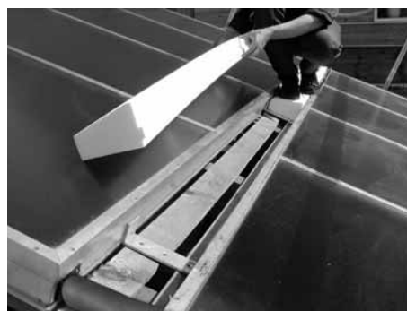
Zwischenblechstützen einlegen
