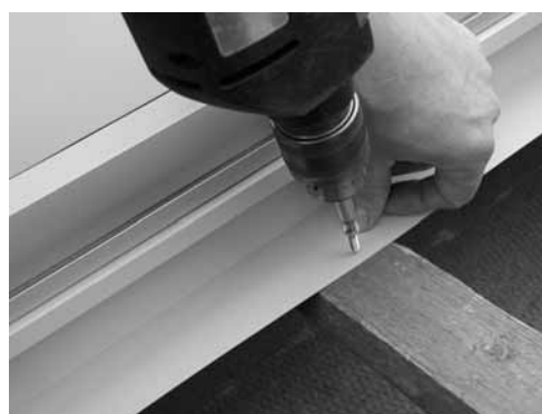
Verbindungsblech verschrauben
