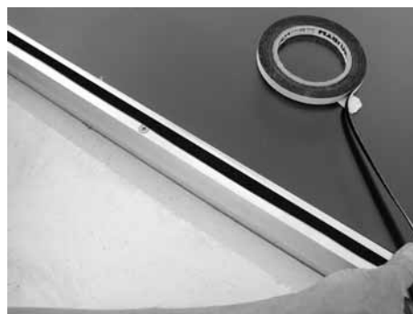
Fugendichtband mittig auf dem Profil durchgehend aufkleben
