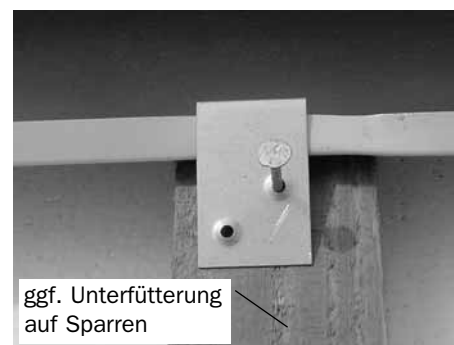
ggf. Unterfütterung auf Sparren Seiten- und Oberbleche fixieren
