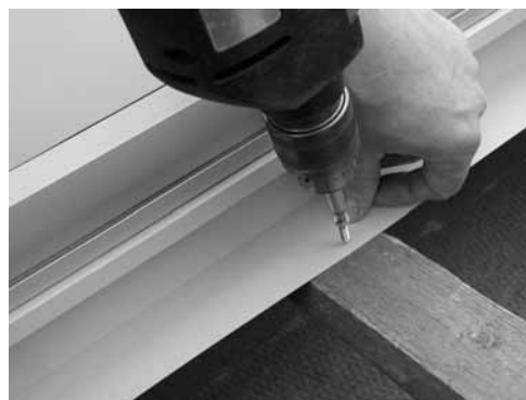
Verbindungsblech verschrauben
