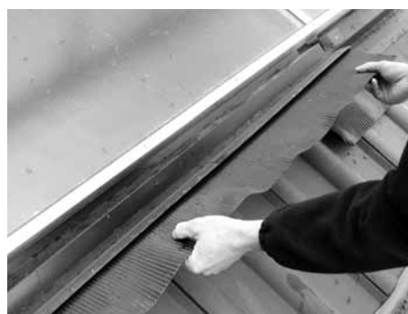
Mittlere Bleischürze einsetzen
