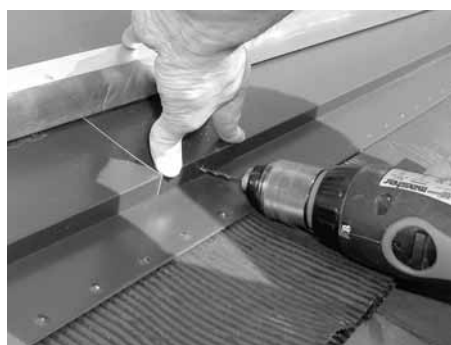
Bleichürzenfixierung andrücken, vorbohren und verschrauben
