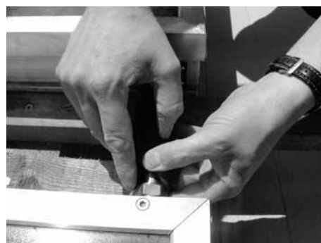
Kollektorverbinder KV-F-Ü am oberen Kollektor verschraubt
