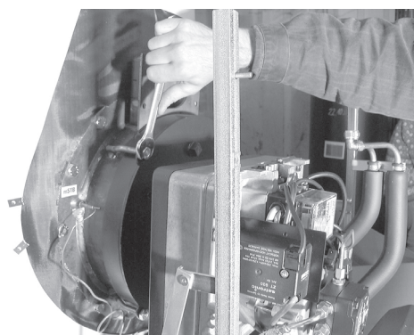
Brenner mit Brennraumbür demontieren
