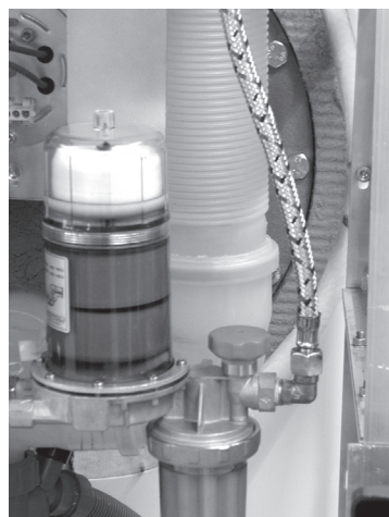
Öl-Zuleitung montiert, nach oben herausgeführt
