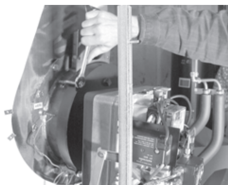
Brenner mit Brennraumtür demontieren
