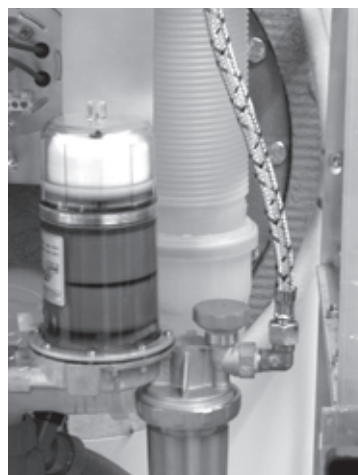
Öl-Zuleitung montiert, nach oben herausgeführt
