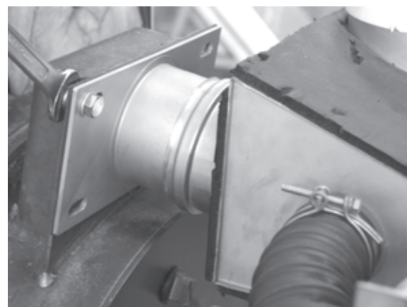
Abgasanschlusskasten abnehmen
