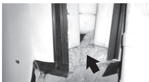
Bereich oberhalb der neuen Flanschisolierung mit Dämmwolle ausfüllen
