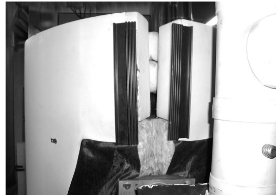
Bild 1: Alte Flanschisolierung demontiert, Speicherisolierung geöffnet
