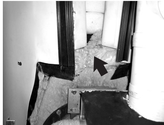
Bild 4: Bereich oberhalb der neuen Flanschisolierung mit Dämmwolle ausfüllen
