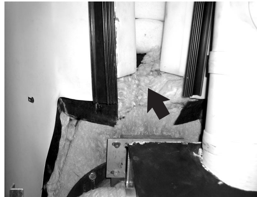
Bild 4: Bereich oberhalb der neuen Flanshisolierung mit Dämmwolle ausfüllen
