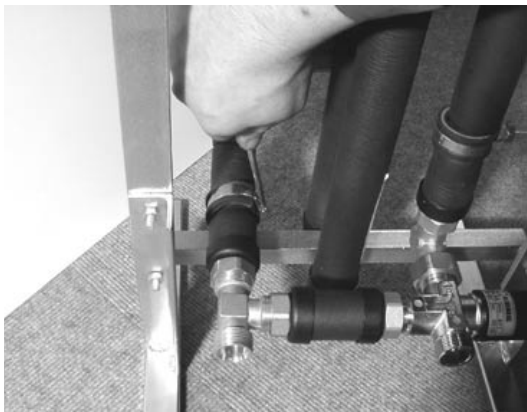
Bild 10: Verschließen der Rohrschellen
