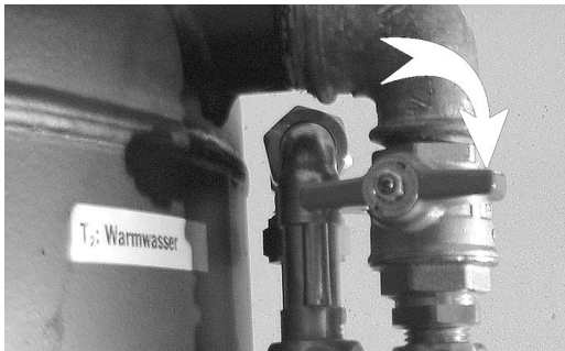
Bild 15: Durchgangs-Kugelhahn oben schließen
