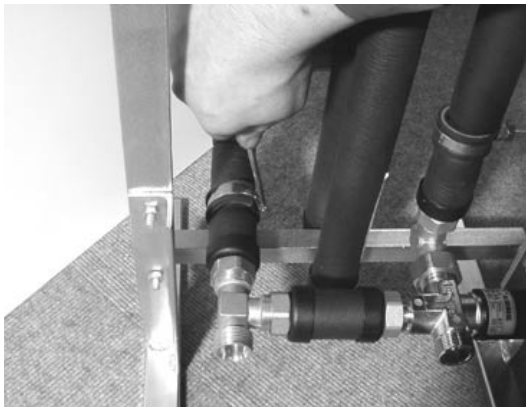
Bild 19: Verschließen der Rohrschellen
