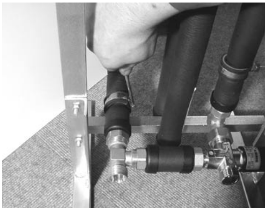
Bild 10: Verschließen der Rohrschellen
