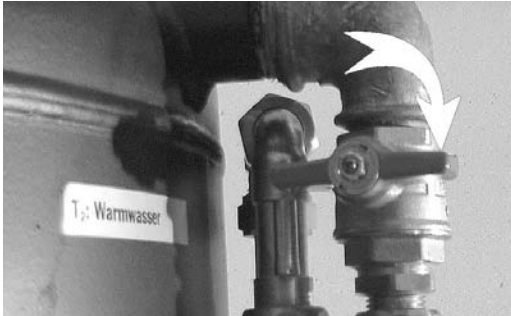
Bild 15: Durchgangs-Kugelhahn oben schließen
