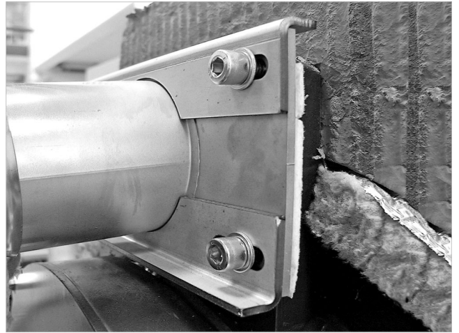
Fig. 6 : Renforcement au niveau de la bride d'évacuation des gaz
