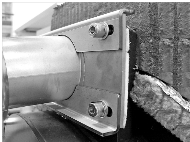
Fig. 3: rinforzo nella flangia di raccordo scarico fumi
