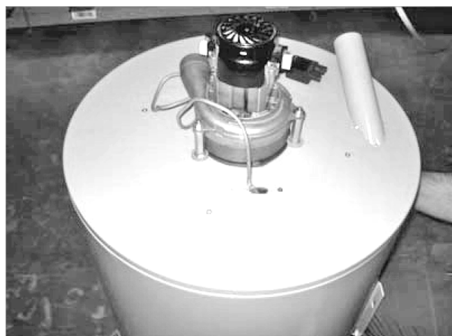
Abb. 2: Neuer Behälterdeckel aufgesetzt
