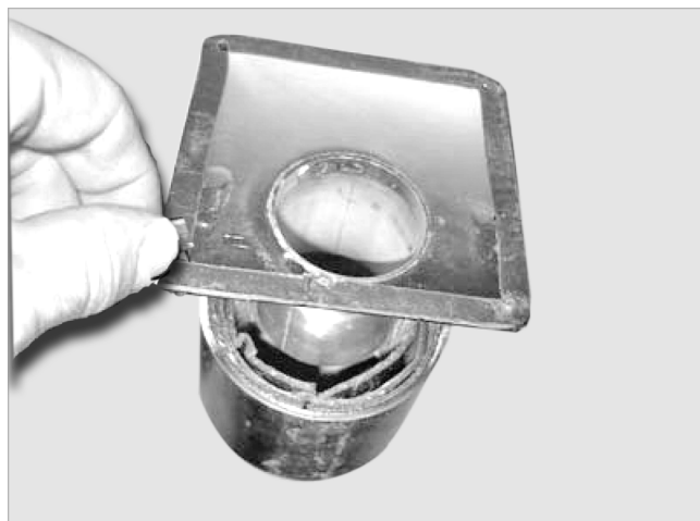
Abb. 13: Flansch mit Dichtband versehen
