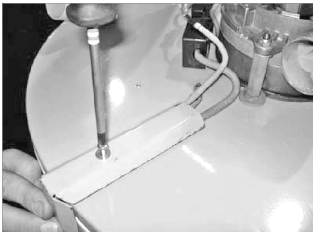
Abb. 6: Kabelleiste anschrauben
