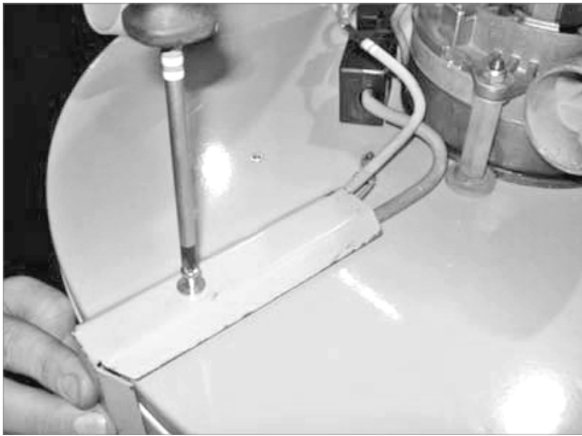
Abb. 6: Kabelleiste anschrauben
