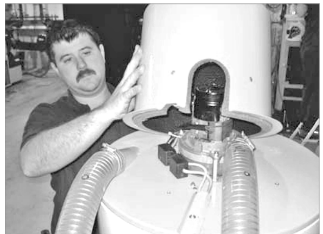
Abb. 10: Haube der Saugturbine aufsetzen
