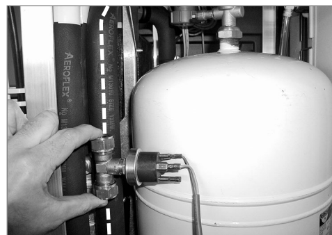
Einbauposition des Druckschalters am Solar-Rücklauf bestimmen
