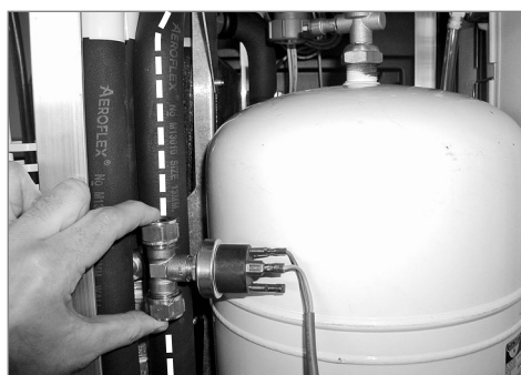
Determinar a posição de instalação do pressostato no circuito de retorno solar
