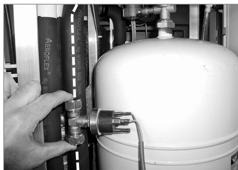
Drukschakelaar op de retourleiding projecteren en de inbouwpositie bepalen
