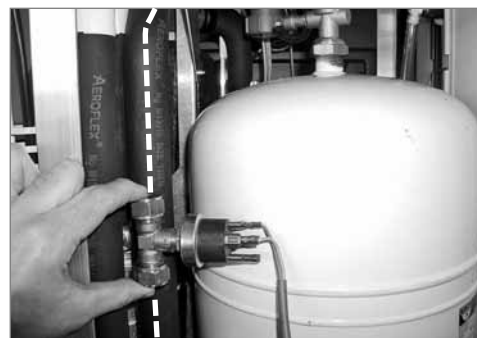
Einbauposition des Druckschalters am Solar-Rücklauf bestimmen
