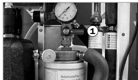
Kugelhahn über dem Solarfilter geschlossen
