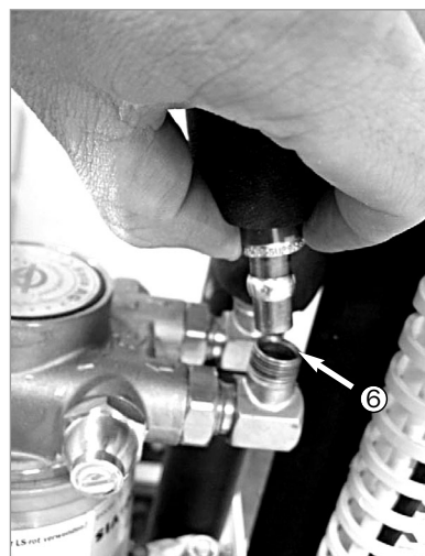
Verbindungsrohr an Pumpe montieren
