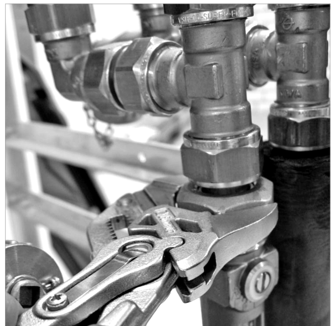
Abb. 11: Anschluss-T-Stück entfernen
