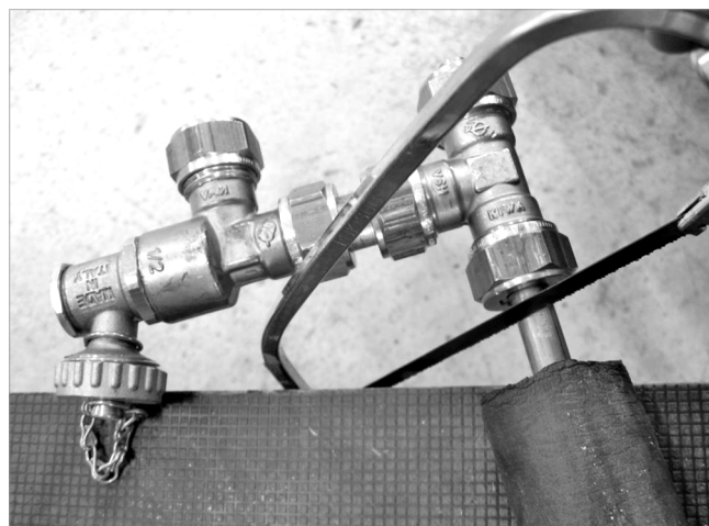
Abb. 6: T-Stück mit KFE-Hahn abtrennen
