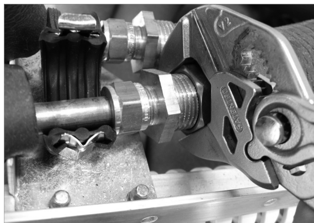
Abb. 5: Speicheranschluss abschrauben
