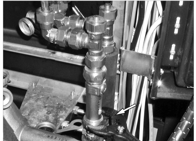
Abb. 10: Anschluss-T-Stück und Abgleichventil mit Innengewinde entfernen
