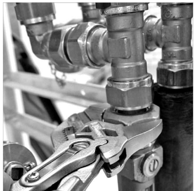
Abb. 11: Anschluss-T-Stück entfernen
