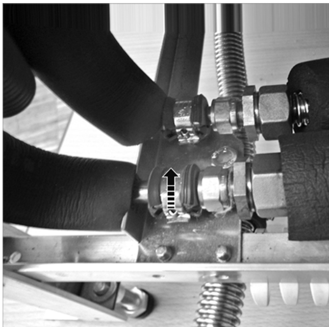
Abb. 4: Rohrschelle unten (und ohne Bild: oben) aufbiegen
