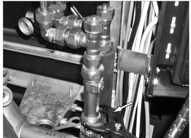
Abb. 10: Anschluss-T-Stück und Abgleichventil mit Innengewinde entfernen
