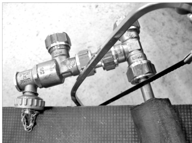
Abb. 6: T-Stück mit KFE-Hahn abtrennen
