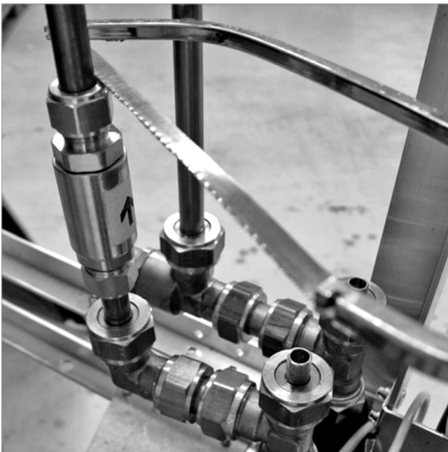
Abb. 9: Oberen Anschluss durchtrennen
