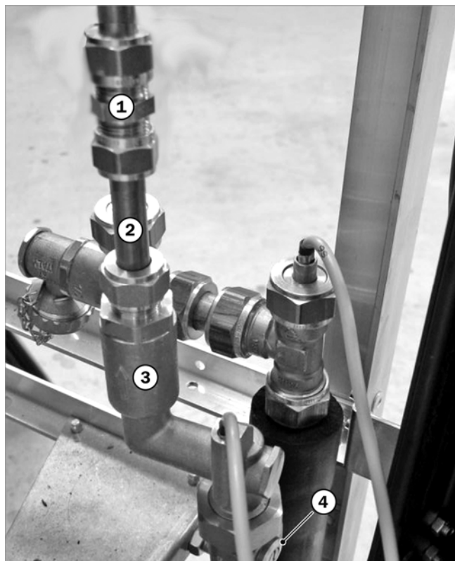
Abb. 12: Anschlusswinkel mit Schwerkraftbremse eingebaut
