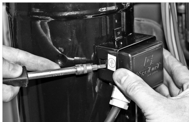
Abb. 2: Anschlussdeckel entfernen
