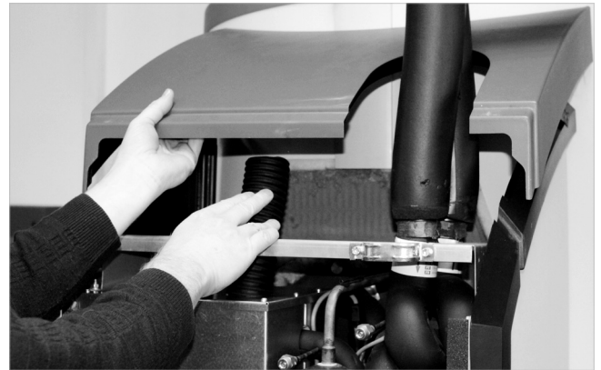
Abb. 16: Schalldämmrohr nach hinten drücken
