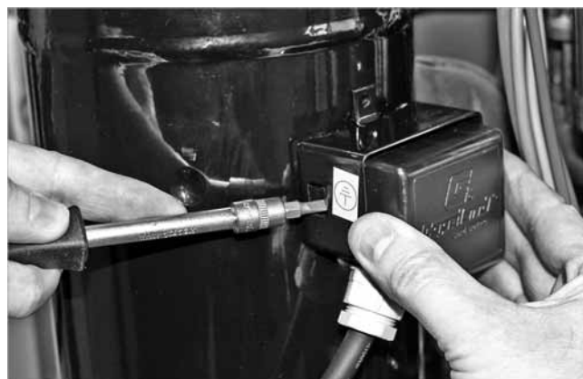
Abb. 2: Anschlussdeckel entfernen
