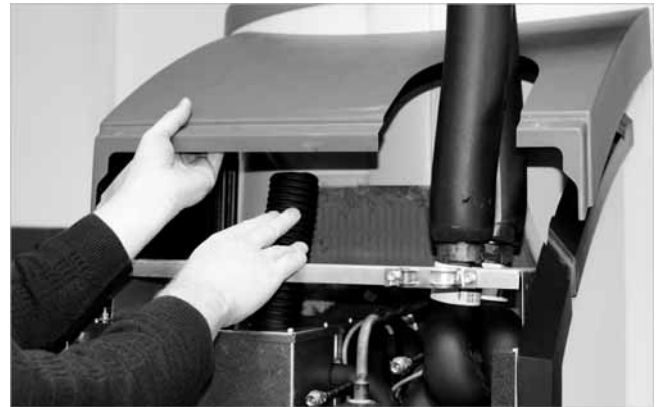
Abb. 16: Schalldämmrohr nach hinten drücken
