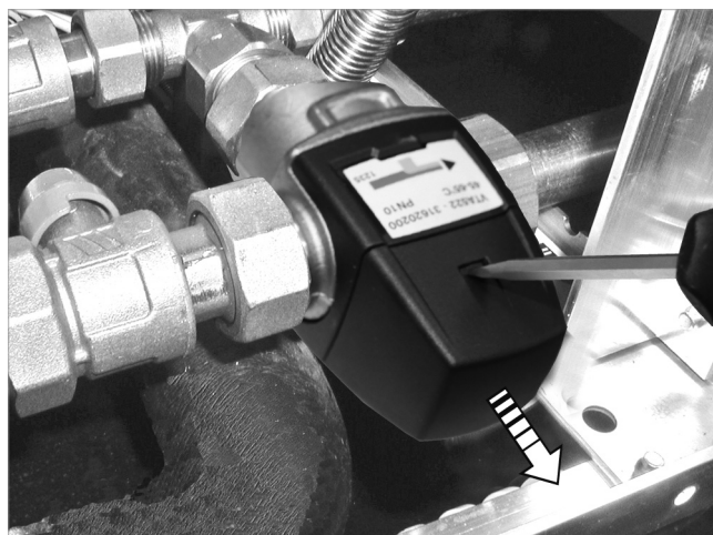
Fig. 6: Retirar la tapa de la válvula mezcladora térmica
