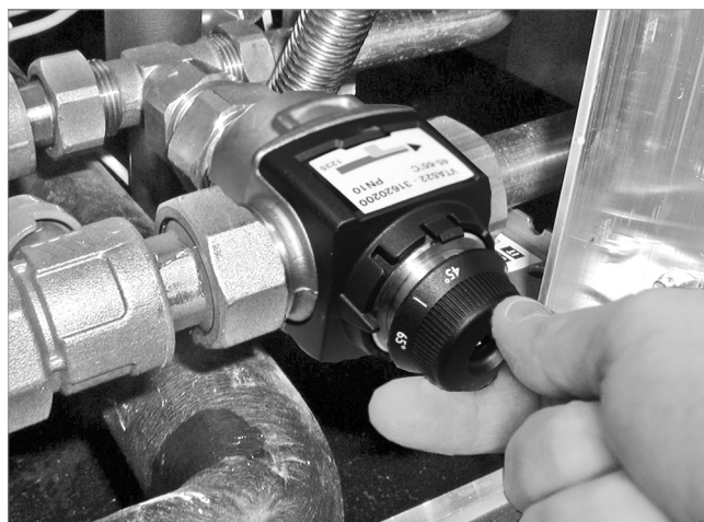
Fig. 7: Ajustar la válvula mezcladora térmica
