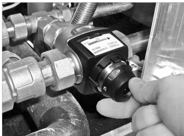
Fig. 7: Ajustar la válvula mezcladora térmica
