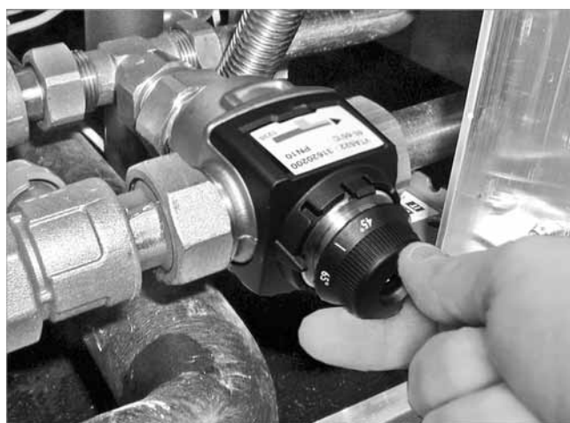
Fig. 7: Regular a válvula TMV
