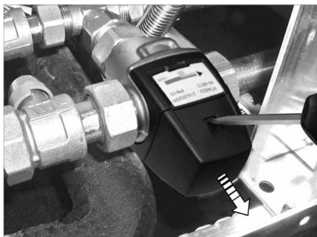
Fig. 6: Remover a capa da válvula TMV
