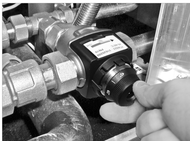
Fig. 7: Regular a válvula TMV
