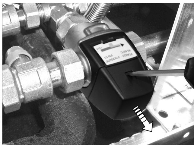
Fig. 6: Remover a capa da válvula TMV
