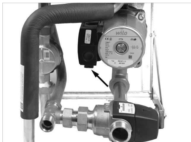
Fig. 3: Collegamento della pompa per l'acqua calda sanitaria
