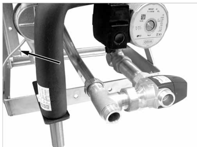
Fig. 5: Posa del cavo VSG-W
