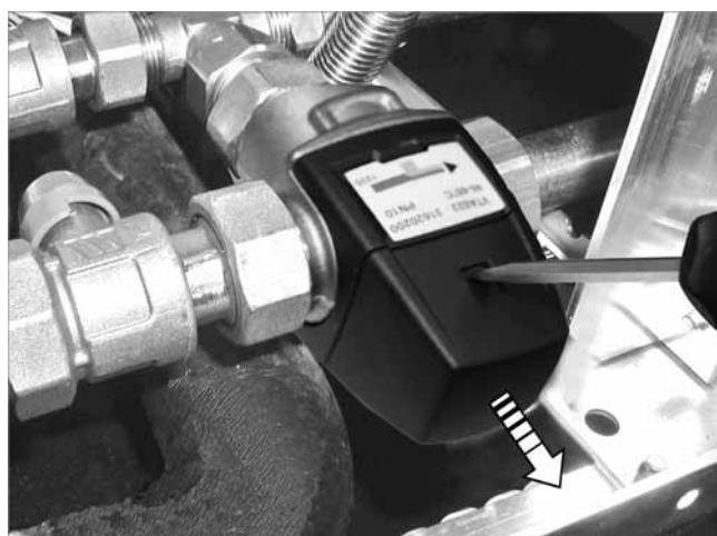
Fig. 6: Rimozione del coperchio della valvola TMV
