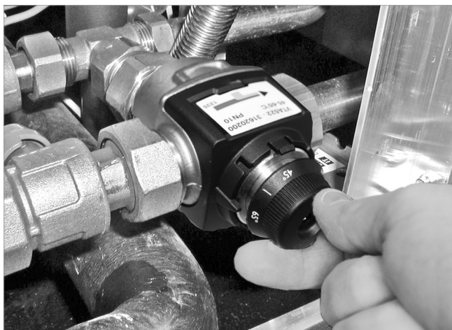
Fig. 7 : Réglage de la vanne mélangeuse thermostatique
