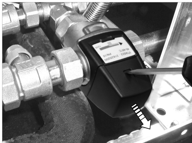
Fig. 6 : Retrait du capuchon de la vanne mélangeuse thermostatique
