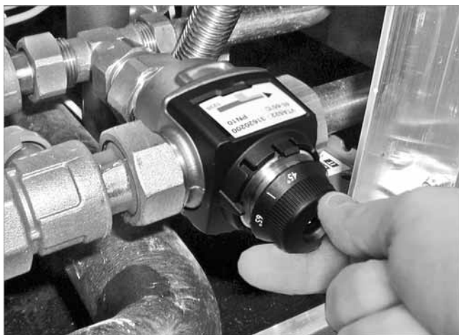
Fig. 7 : Réglage de la vanne mélangeuse thermostatique
