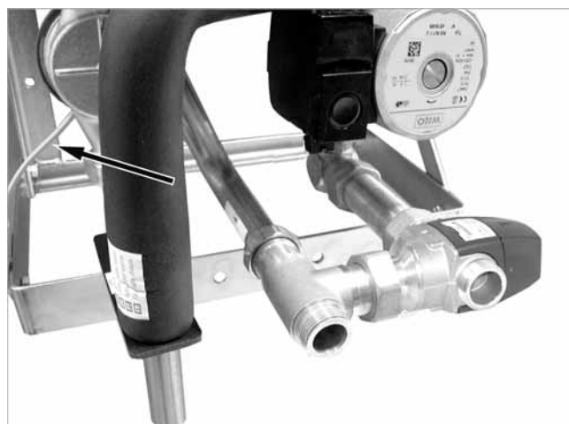
Fig. 5 : Pose du câble VSG-W
