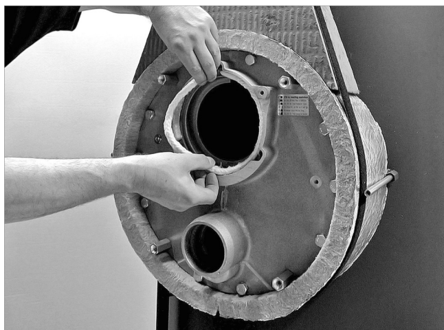
Abb. 8: Brennerdichtschnur einlegen
