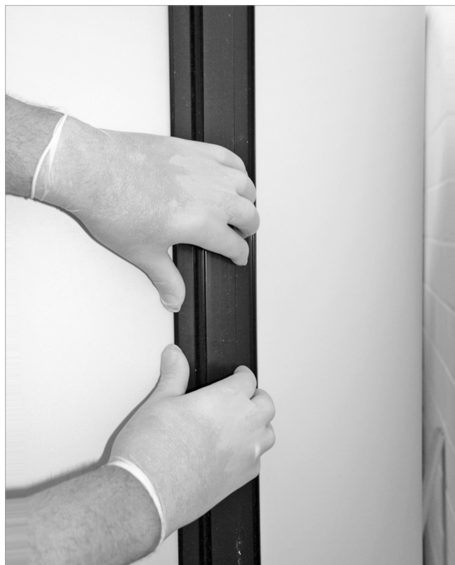
Abb. 53: Isolierung hinten schließen
