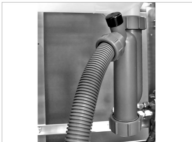
Abb. 29: Siphon mit Kondensatschlauch montieren
