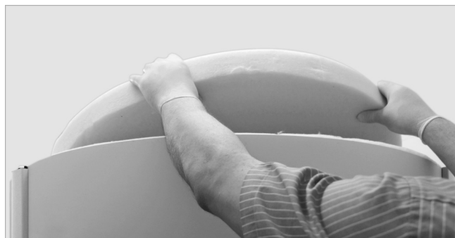
Abb. 55: Deckelrunde auflegen
