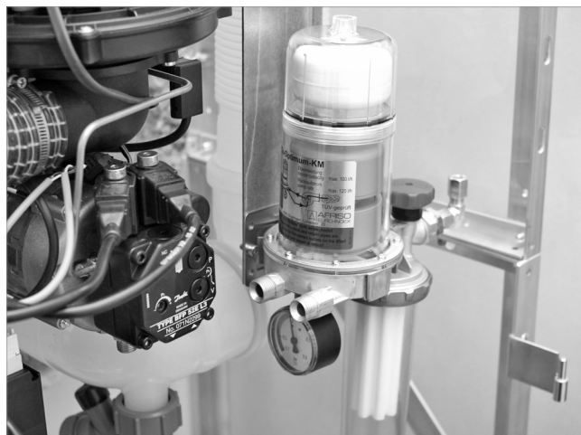
Abb. 26: Ölfilter einhängen
