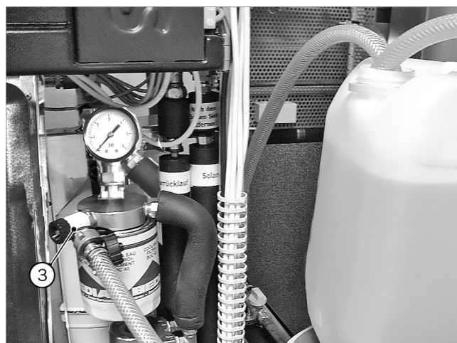
Abb. 66: Füllhahn am Filterdeckel (mit montiertem Solarkreisfilter)
