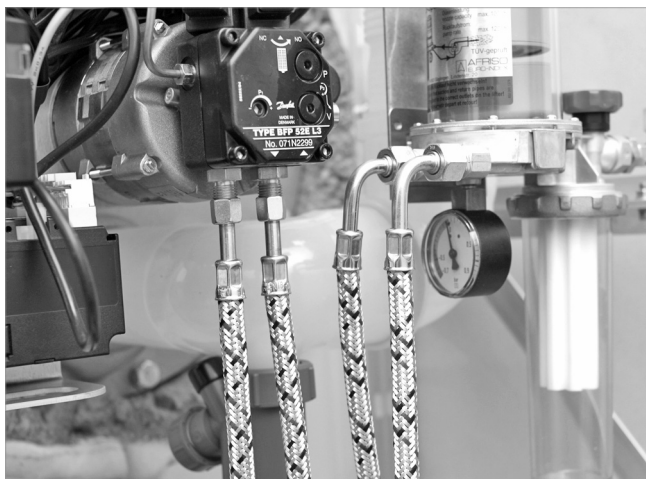
Abb. 27: Ölleitungen anschließen
