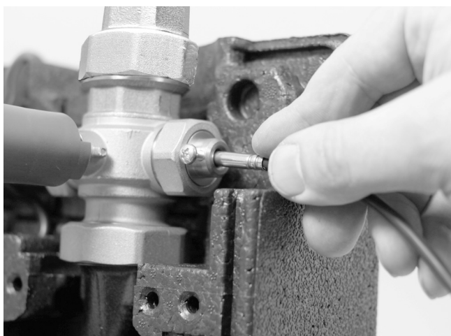
Abb. 46: Vorlauftemperatursensor montieren
