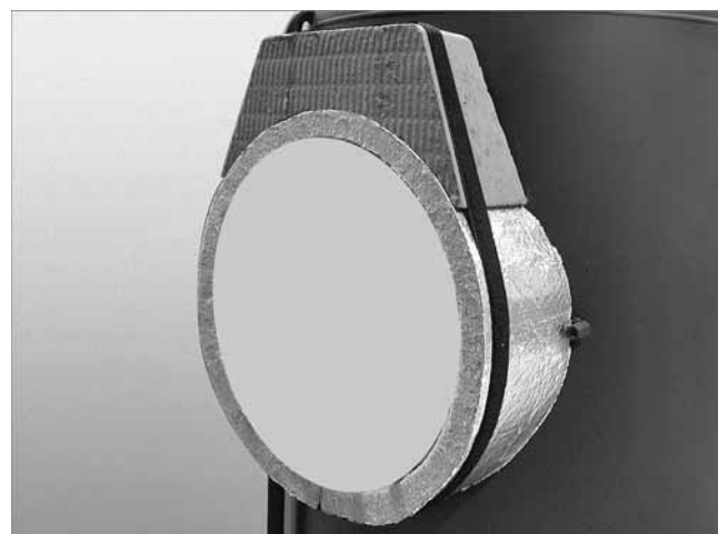
Abb.6: Flanschisolierung fixieren
