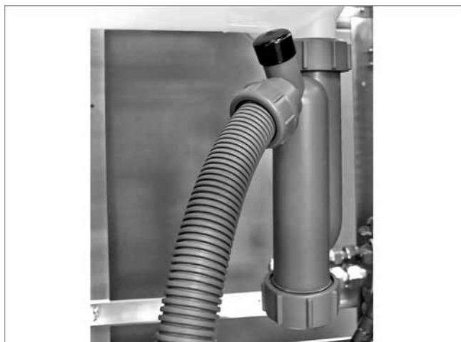
Abb. 29: Siphon mit Kondensatschlauch montieren
