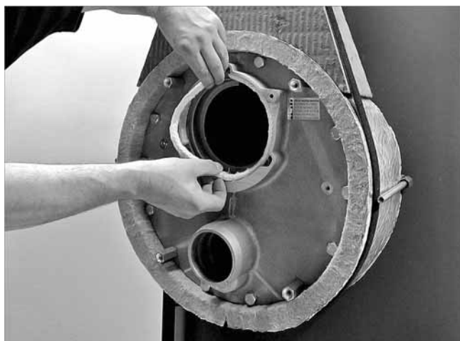
Abb. 8: Brennerdichtschnur einlegen
