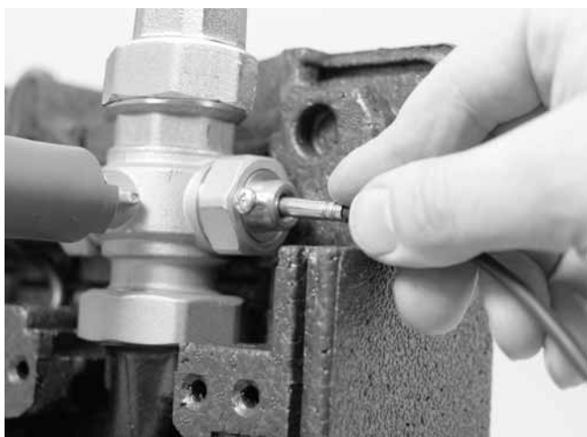
Abb. 46: Vorlauftemperatursensor montieren
