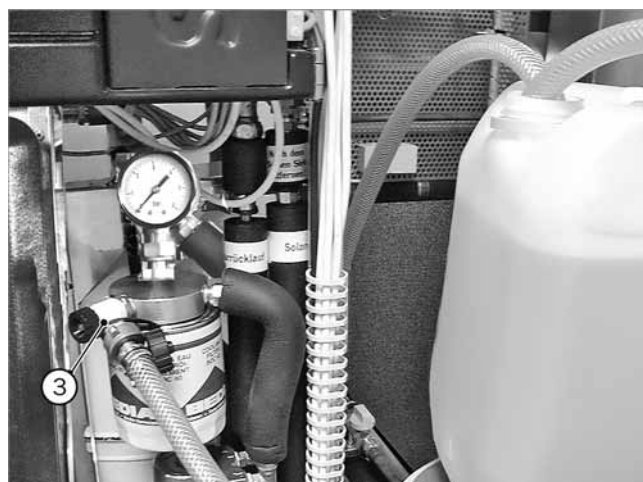
Abb. 66: Füllhahn am Filterdeckel (mit montiertem Solarkreisfilter)
