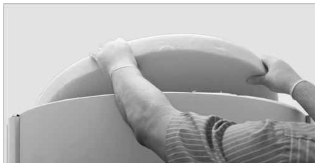
Abb. 55: Deckelrunde auflegen
