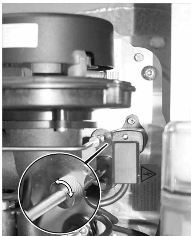
Abb. 78: Rändelmutter (Anschluss Ölleitung / Düsenstock)
